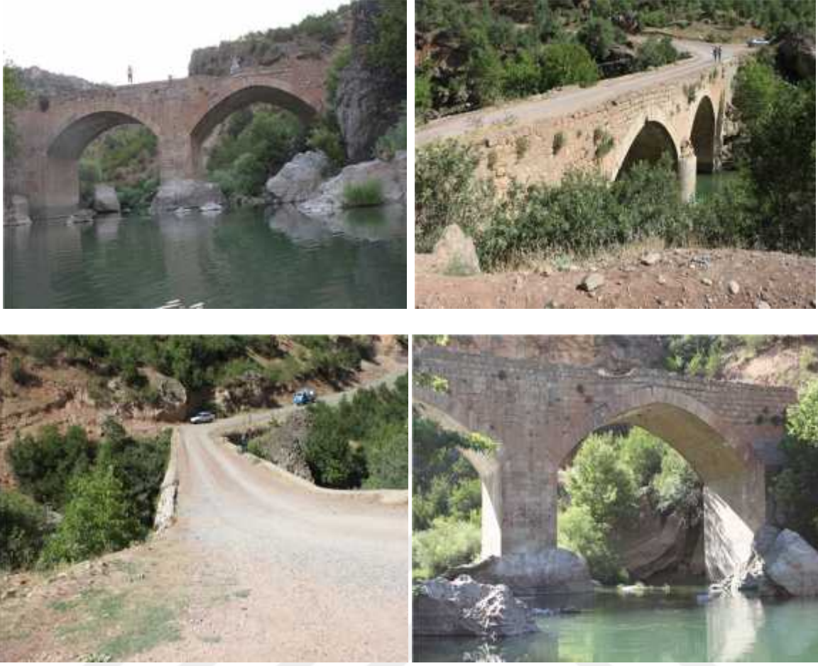
Şekil 2.3. Göderni Köprüsü'ne ait bazı görüşler
