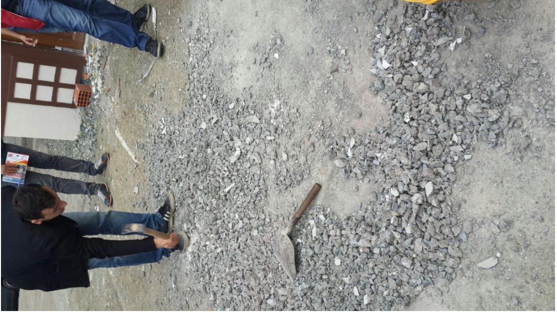
Şekil 17. Beton inşaat yıkıntı atığından (İYA) geri dönüşüm agregası (GDA) temini
