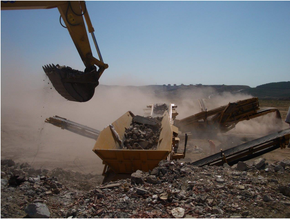
Şekil 7. İnşaat yıkıntı atıklarının eleğe alınması işlemi [47].
