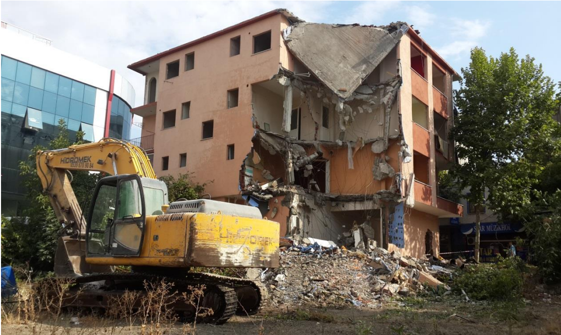
Şekil 1. Yıkımı yapılan betonarme bina
