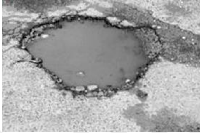
Şekil 13. Bitümlü sıcak karışımlarda çökme (Yılmaz, 2016).
