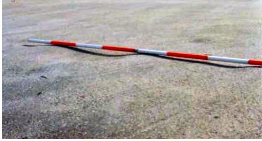
Şekil 14. Kaplamalarda ondülasyon oluşumu (Yılmaz, 2016).
