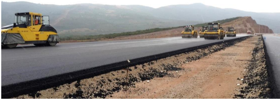
Şekil 7. Bitümlü sıcak karışım sıkıştırma çalışmaları
