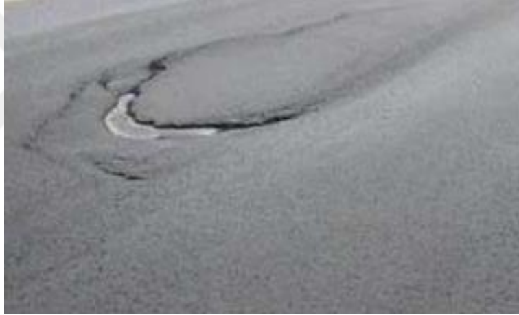
Şekil 12. Bitümlü sıcak karışımlarda oturma (Yılmaz, 2016).
