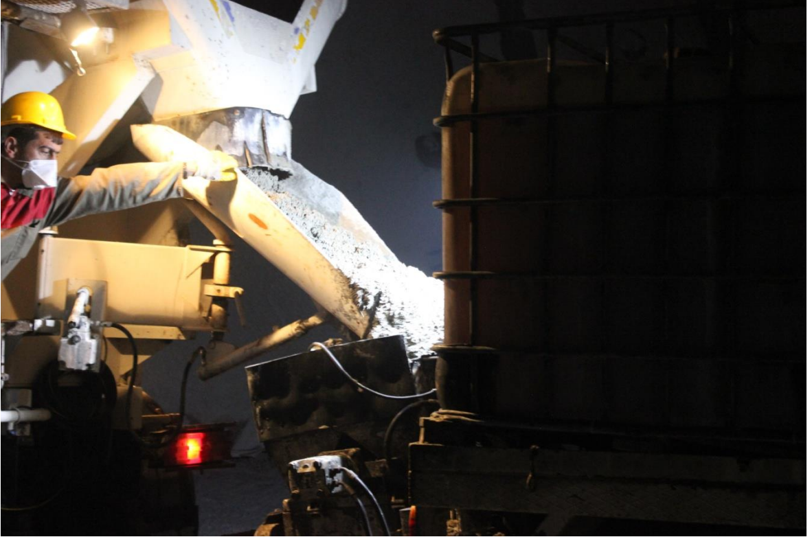
Şekil 76. Sentetik fiberli püskürtme betonunun pompaya iletim şekli
