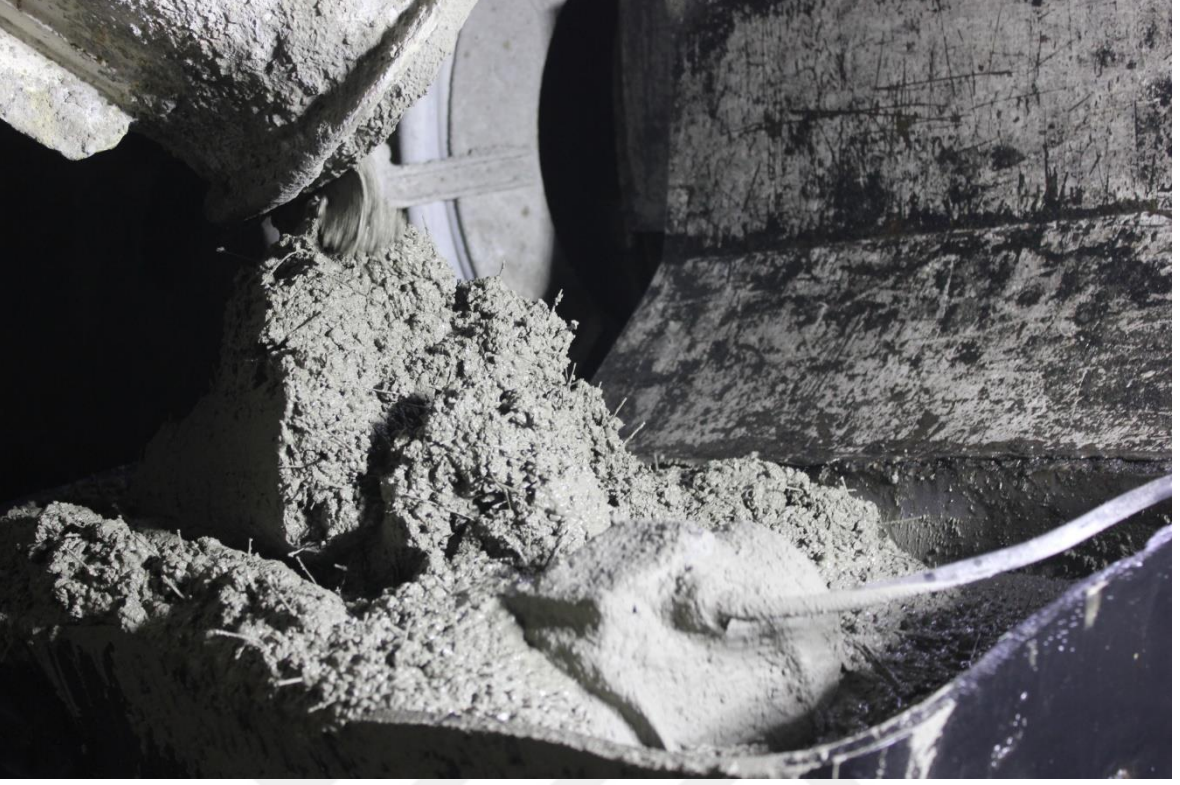
Şekil 77. Sentetik fiberli püskürtme betonunun pompaya iletim anı
