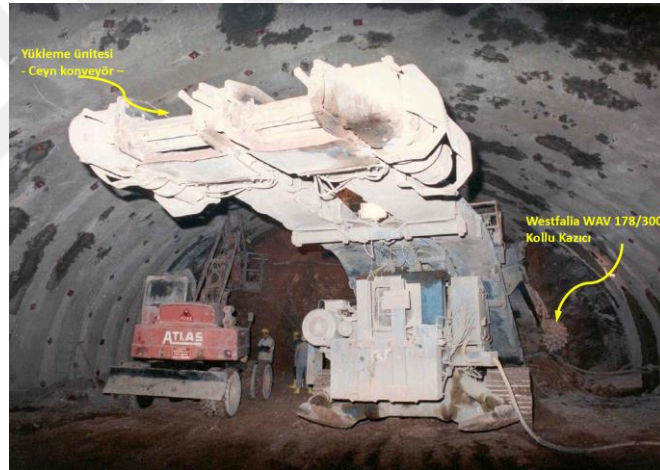
Şekil 11. Kollu tünel açma makinesi (Arıoğlu, 2009).
