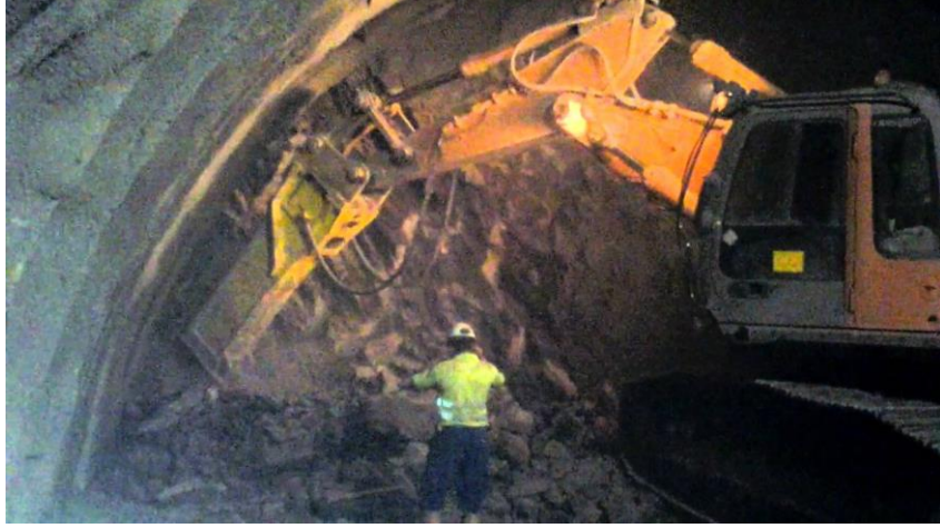
Şekil 12. Darbeli tünel açma makinesi (Hammer)
