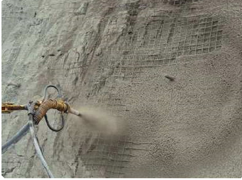
Şekil 1.3. Püskürtme beton uygulaması
