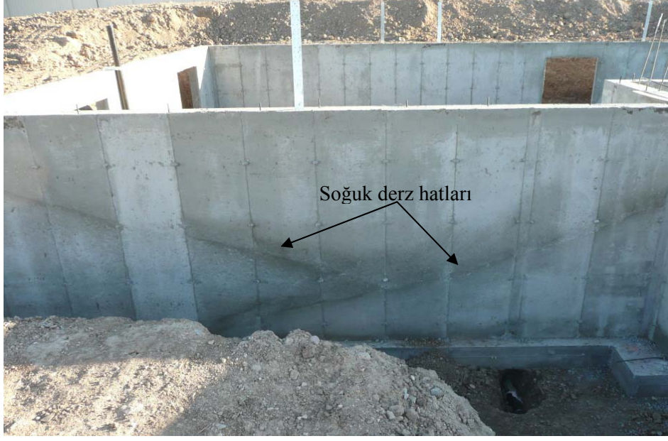
Şekil 1.38. Betonda soğuk derz örneği
