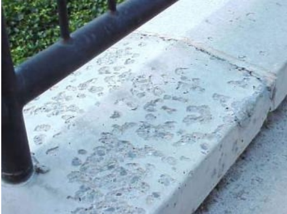
Şekil 1.34. Donma çözülme olayının etkisinin görüldüğü bir örnek
