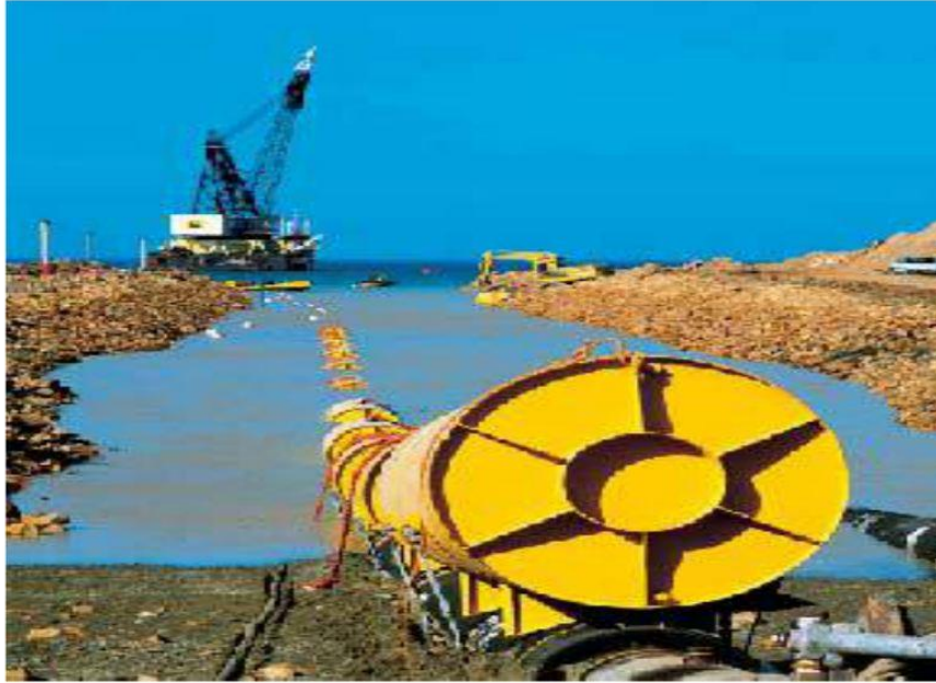
Şekil 3.17. Dubalar bağlanmış çekilmeye hazır bir durumda bekleyen boru hattı
