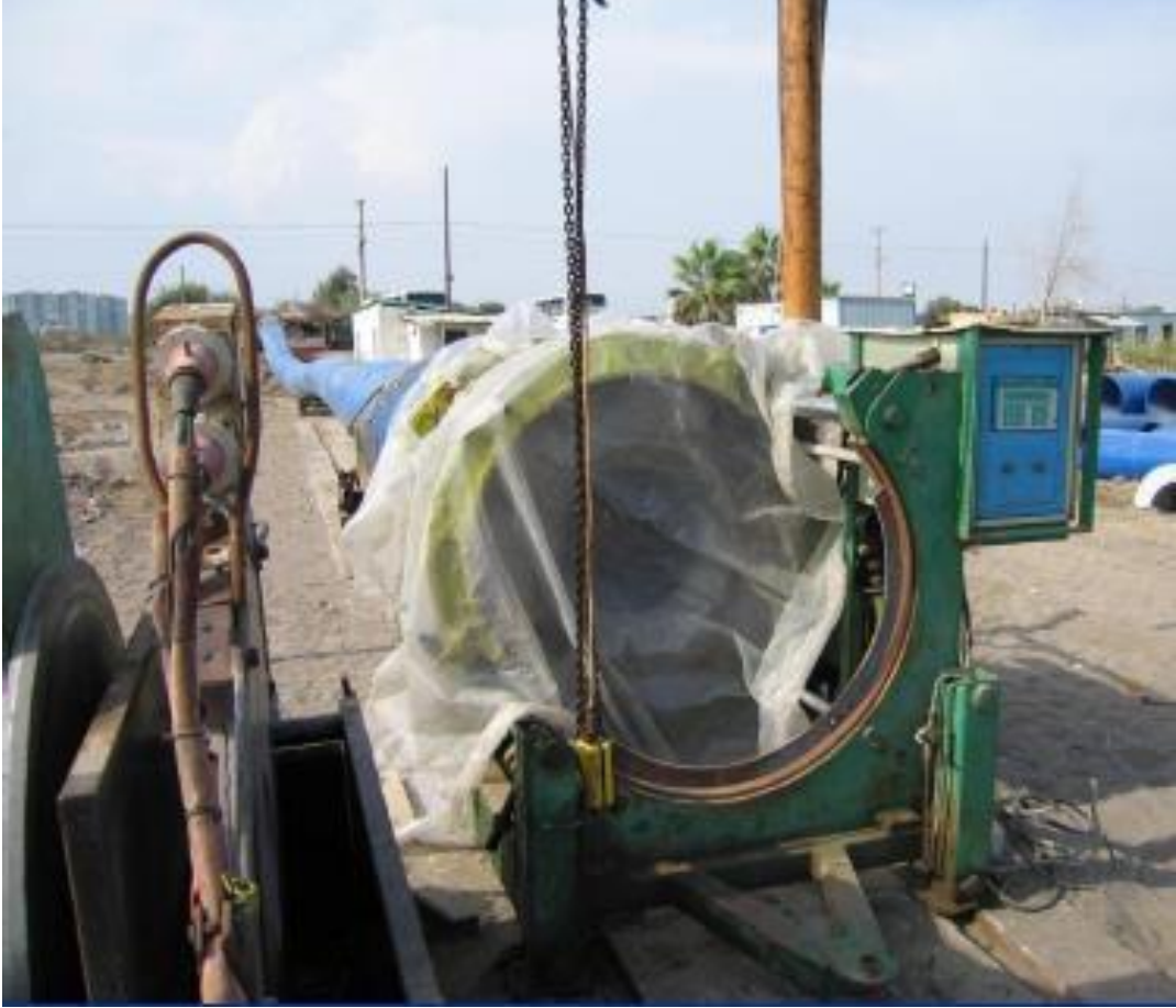
Şekil 3.3. YYPE boru kaynağının yapılması
