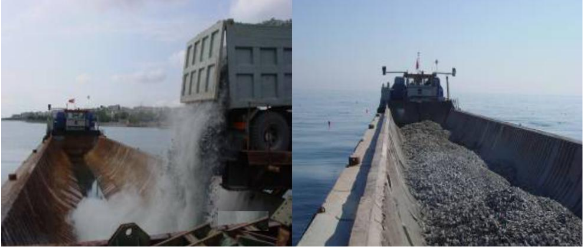
Şekil Ek-2.5. Boru üzeri dolgusu (Karakaş vd., 2007)
