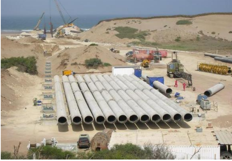
Şekil 3.5. Deniz deşarjı şantiyesi
