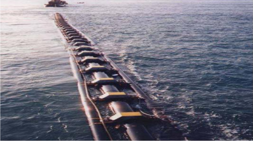
Şekil 3.13. Çekme vincine sahip bir gemi tarafından yüzdürülen boru hattı
