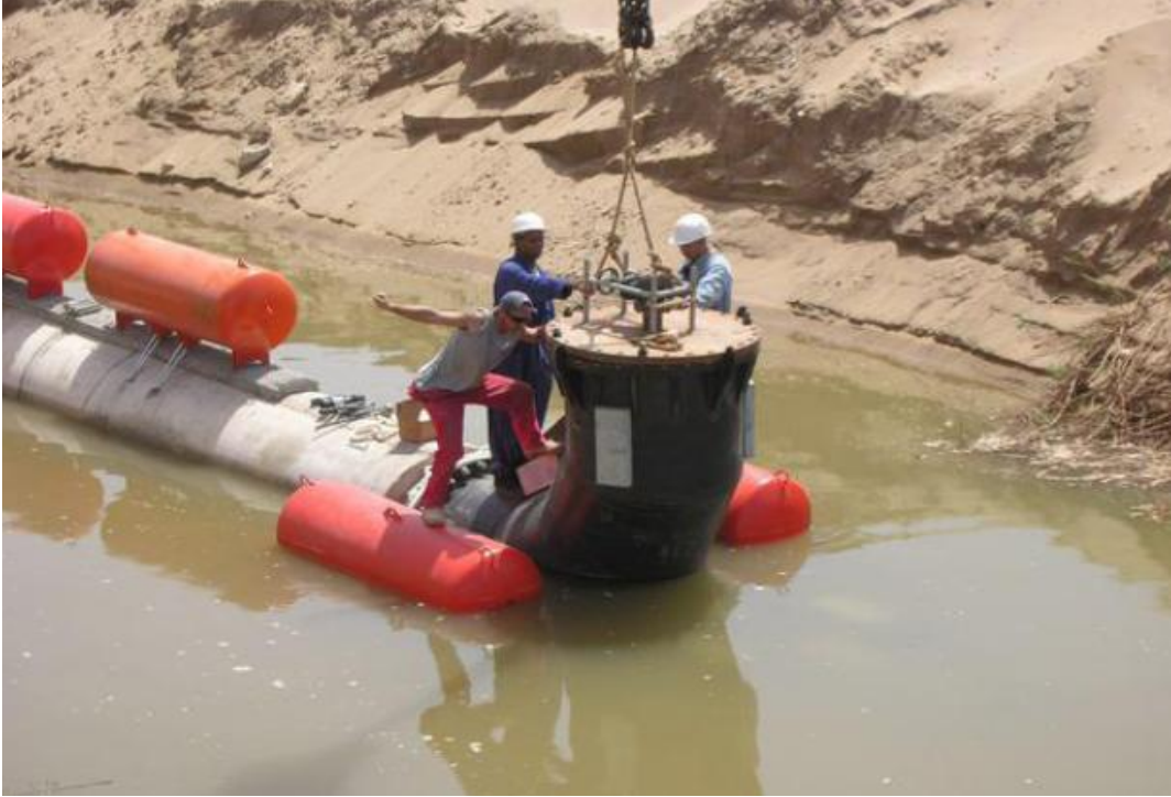
Şekil 3.14. Çelik borular için yüzdürme metodu
