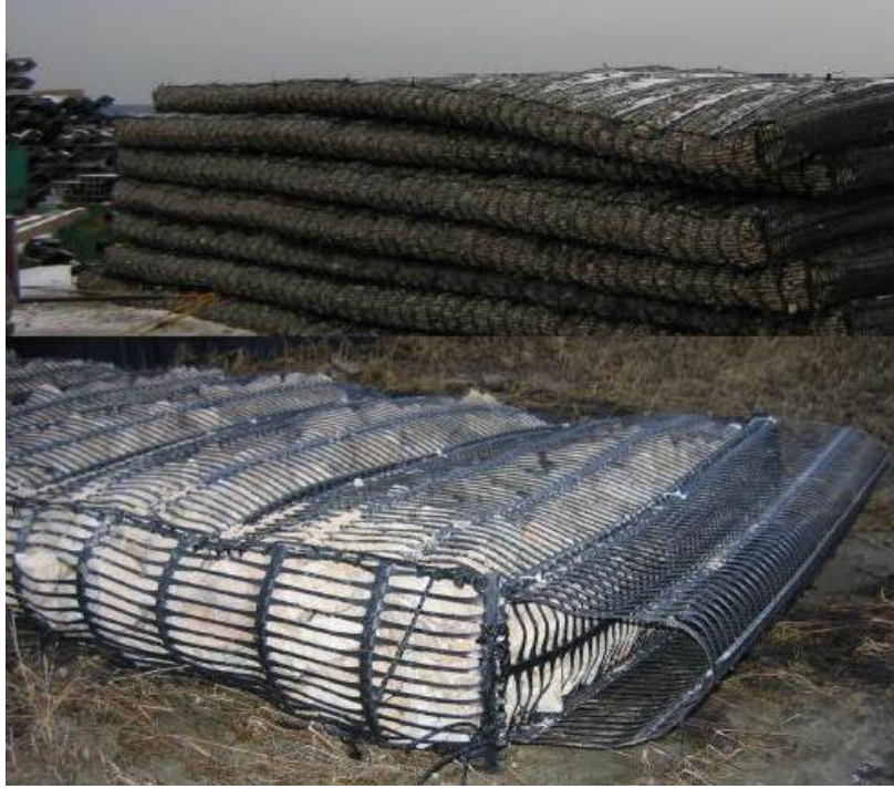
Şekil 3.8. Gabion hazırlıkları
