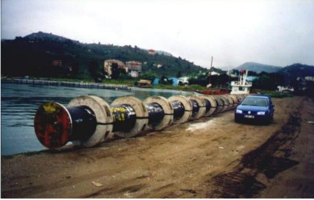
Şekil 3.4. YYPE borular için batırma blokları
