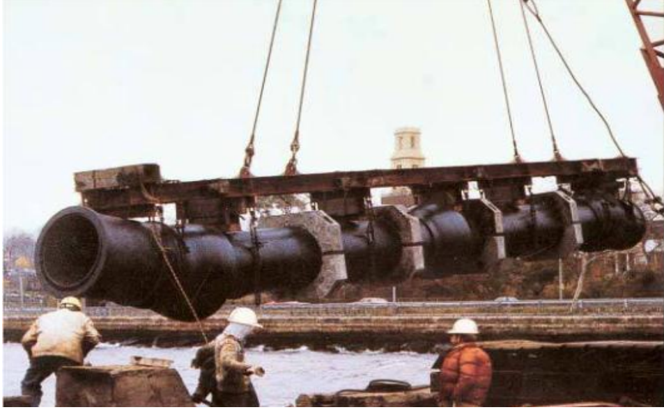
Şekil 3.22. Borunun zarar görmesini engelleyene boru tutucu gövde
