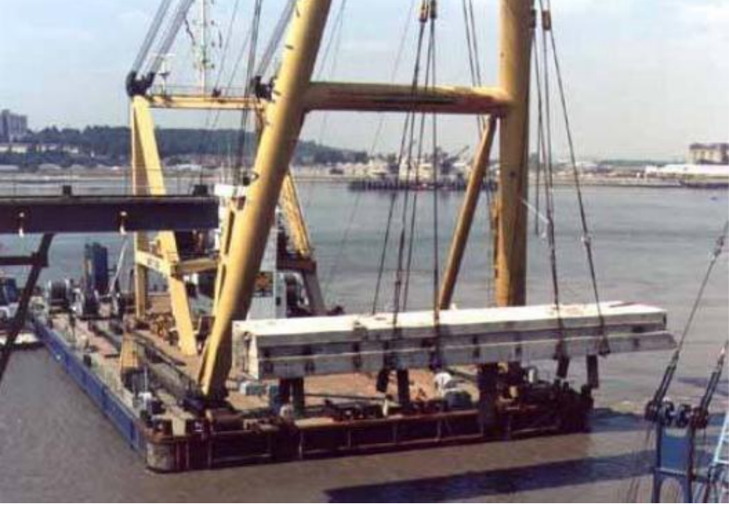
Şekil 3.21. Deniz altında boru hattı döşenmesinde kullanılan vinçli döşeme gemisi
