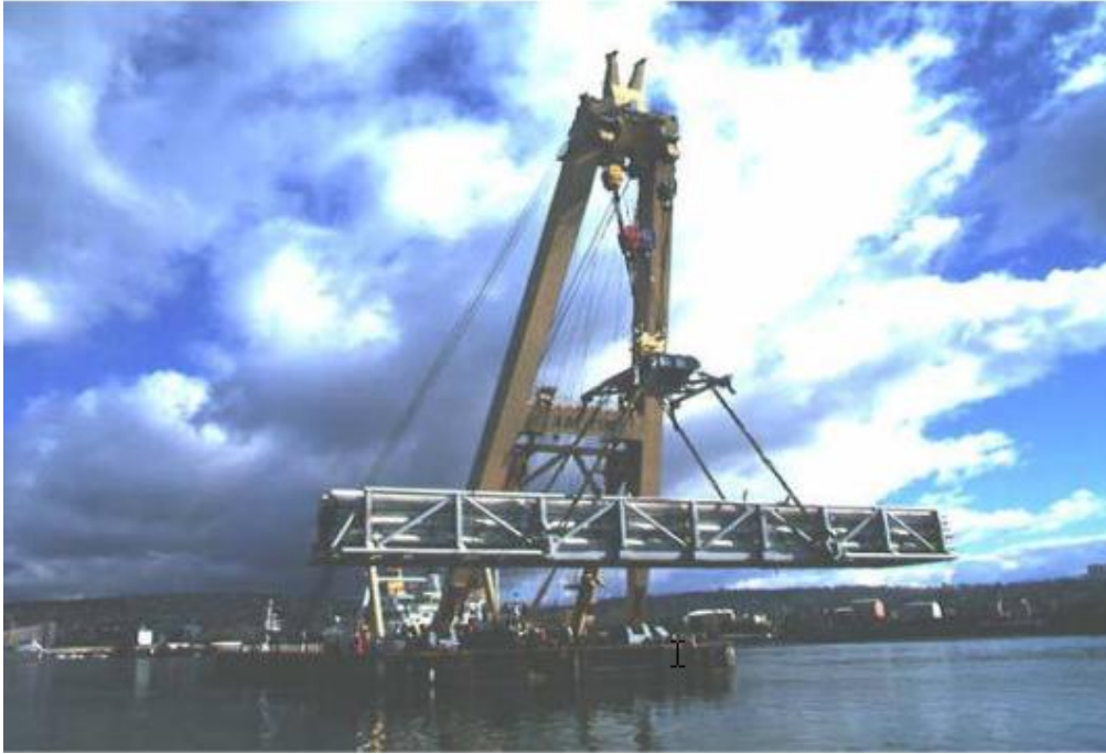
Şekil 3.20. Deniz altında boru hattı döşenmesinde kullanılan vinçli döşeme gemisi
