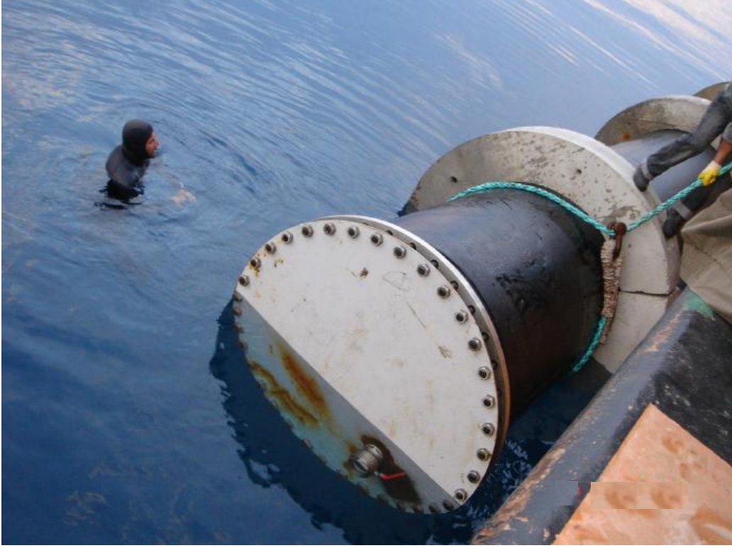
Şekil 3.15. YYPE borular için yüzdürme metodu
