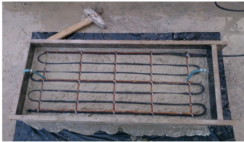
Şekil 14. Kabloların 13 cm beton döküldükten sonraki durumu
