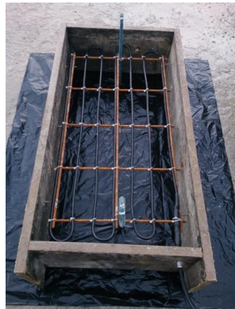
Şekil 12. Isıtıcı kablonun beton dökülmeden önceki durumu
