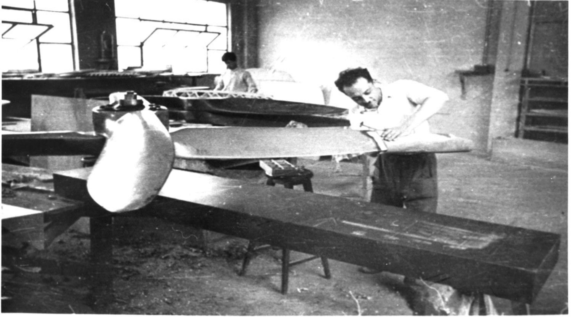
Uçak Fabrikasındaki pervane üretimi.
