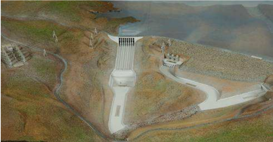
Şekil 14. Iısu Barajı'nın inşaat sonu görünümü
