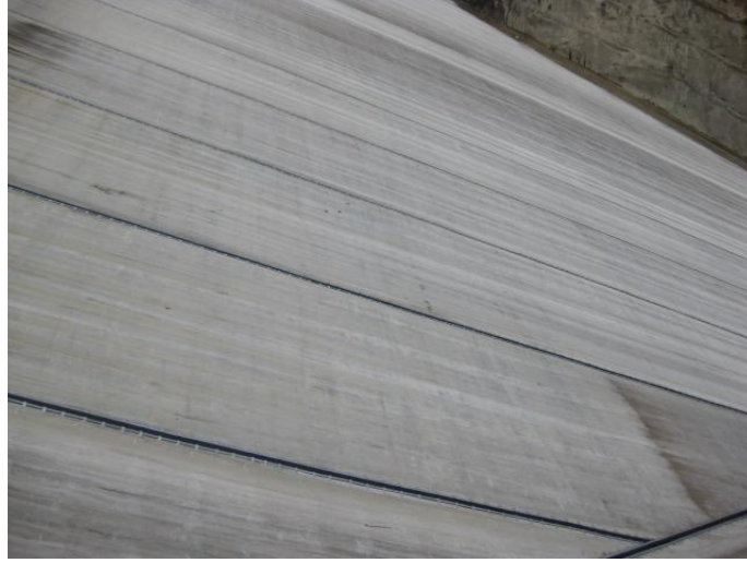
Şekil 2. Atasu barajı önyüz beton uygulaması
