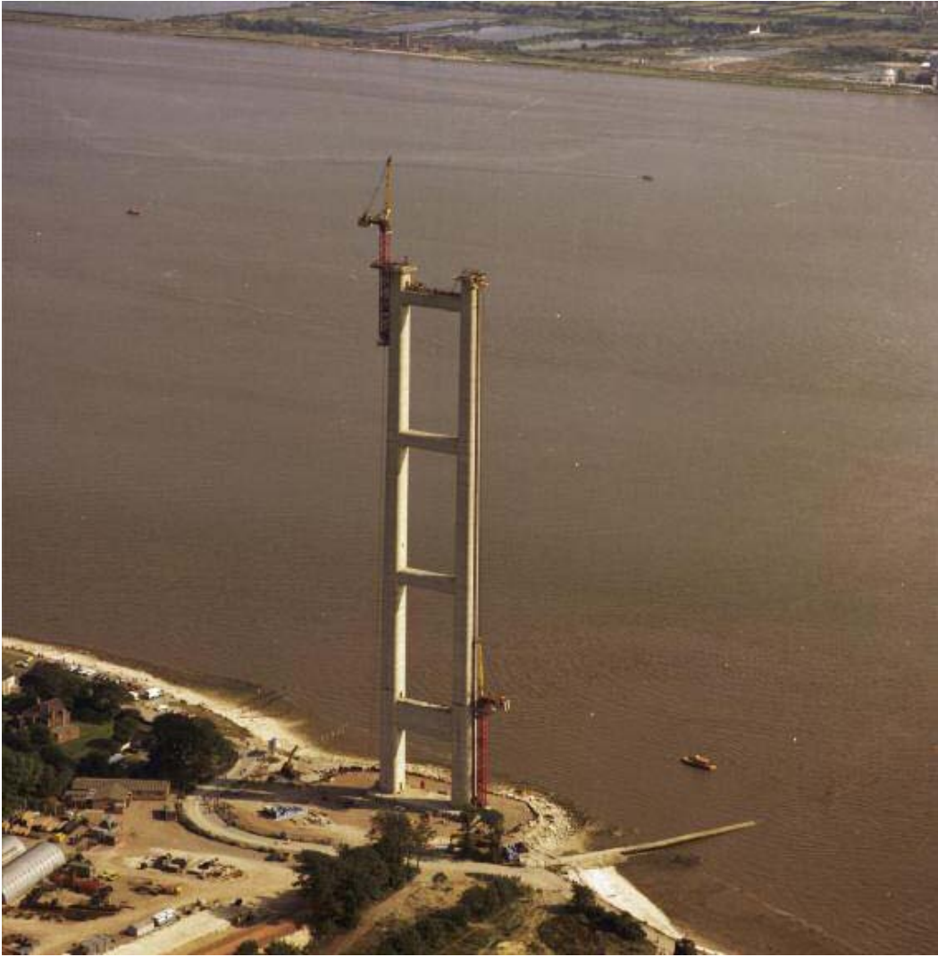
Şekil 2.29. Humber Köprüsü kulelerinin yapım aşamalarına ait bazı fotoğraflar (URL-11, 2010).
