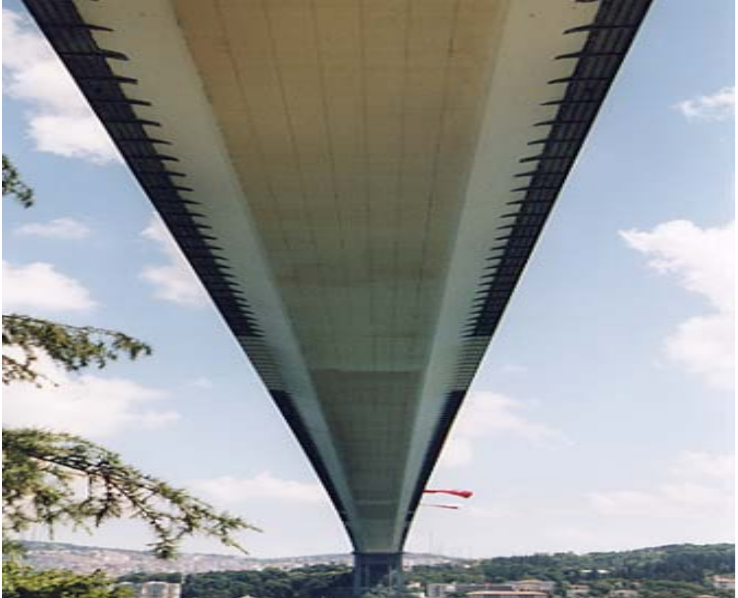
Şekil 2.14. Boğaziçi Köprüsü tabliye yapım aşamalarına ait bazı fotoğraflar (URL-5, 2010).
