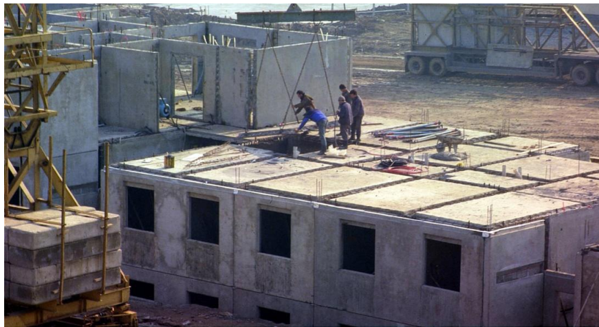
Şekil 1.30 Prefabrike Panolu Sistemler (Uçar, Barka, 2011)
