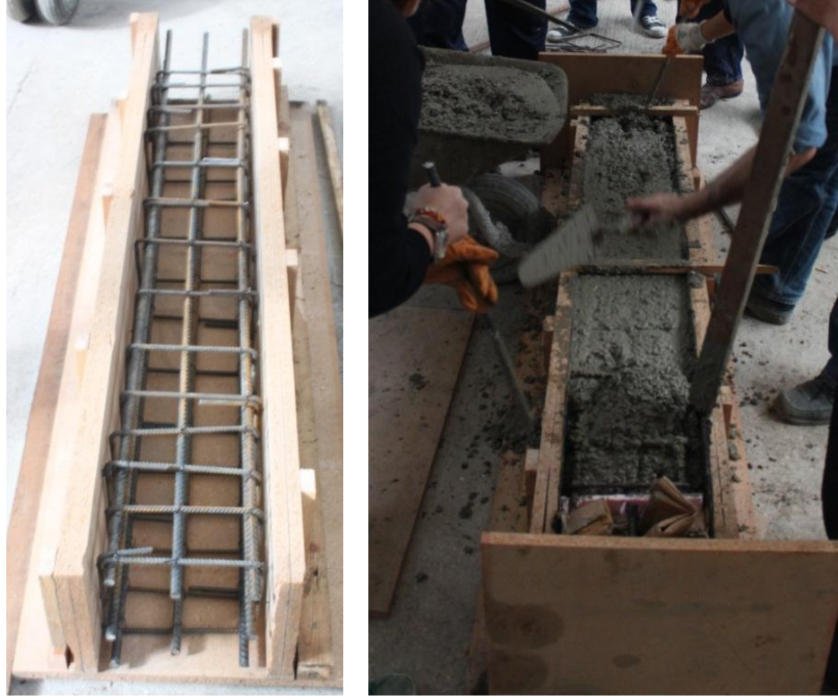
Şekil 2.10. Prefabrike kolon donatıları ve beton dökümü
