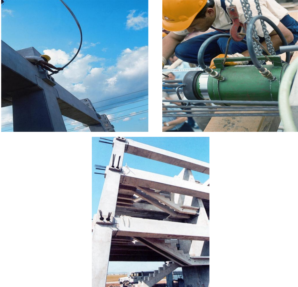
Şekil 1.33 Ardgermeli Prefabrike Yapı İnşaatı (Uçar, Barka, 2011)
