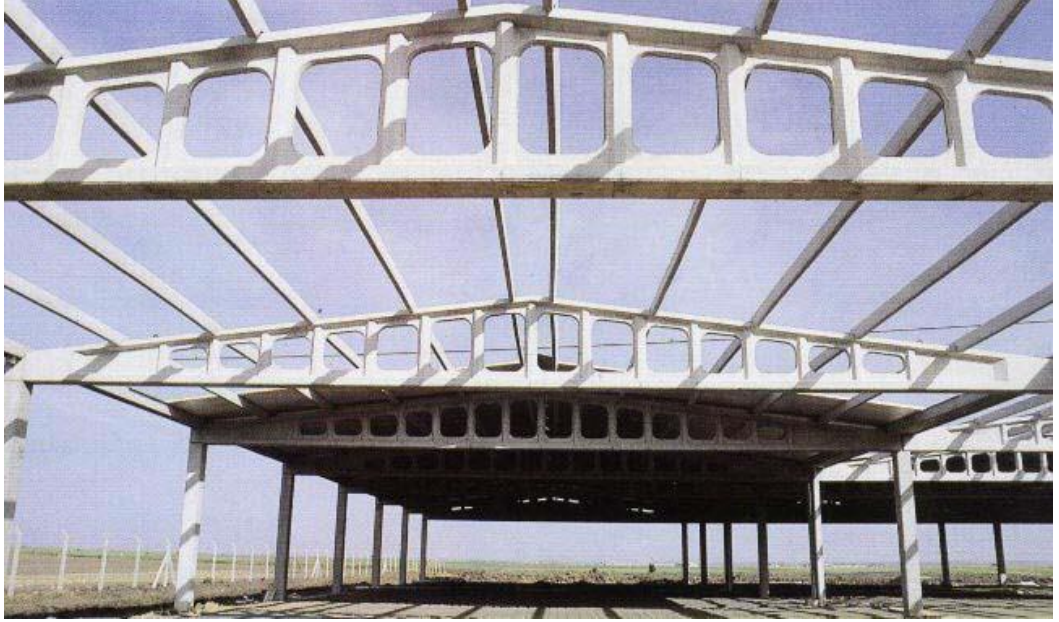
Şekil 1.8. Prefabrike boşluklu makas
