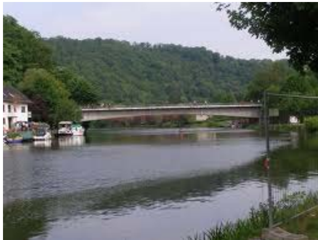
Şekil 1.2. Balduin Köprüsü, Almanya
