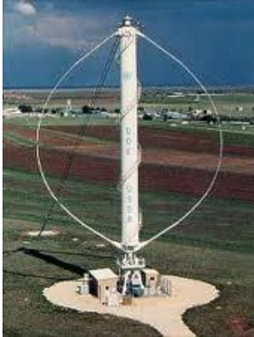
Şekil 1.7. Düşey eksenli türbin
