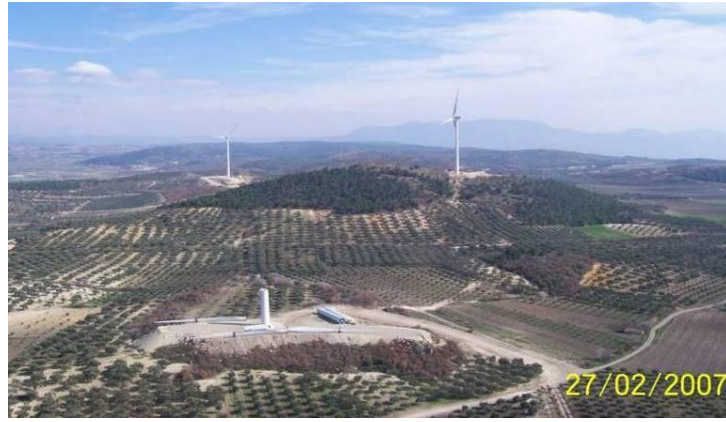
Şekil 1.10. Manisa’daki rüzgar santrali, kurulu gücü: 6 \times 1800 \text{ KW} = 10,8 \text{ MW}
