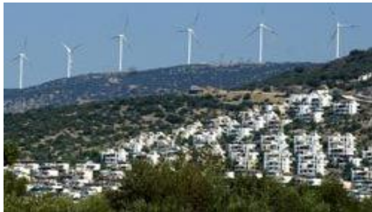
Şekil 1.11. Aydın’daki Akbuk RES, kurulu gücü: 21 \times 1500 \text{ KW} = 31,5 \text{ MW}
