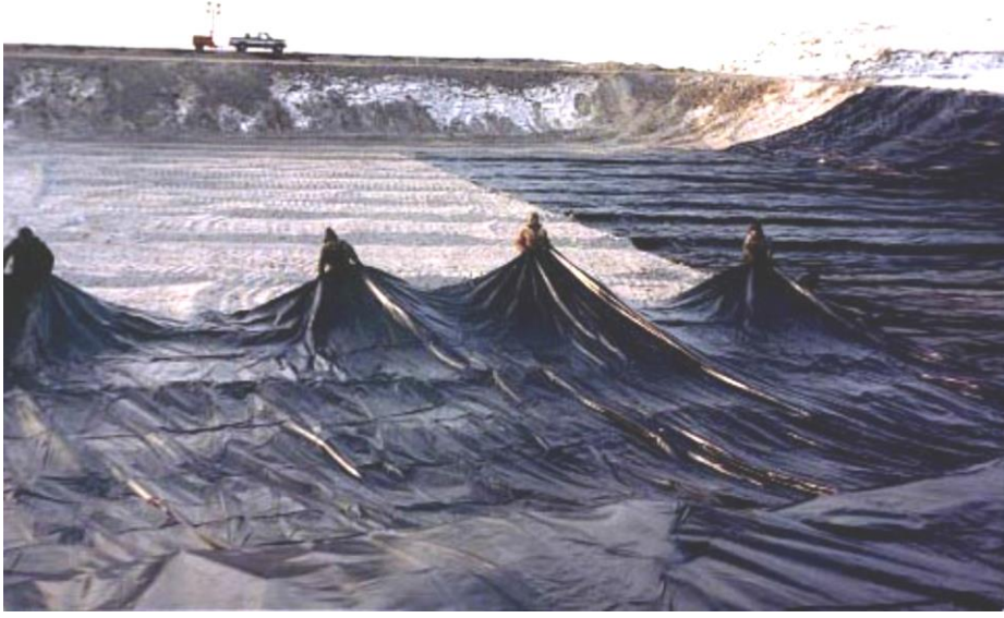
Şekil 1.38. Geomembranın saha uygulaması (URL-7, 2013)
