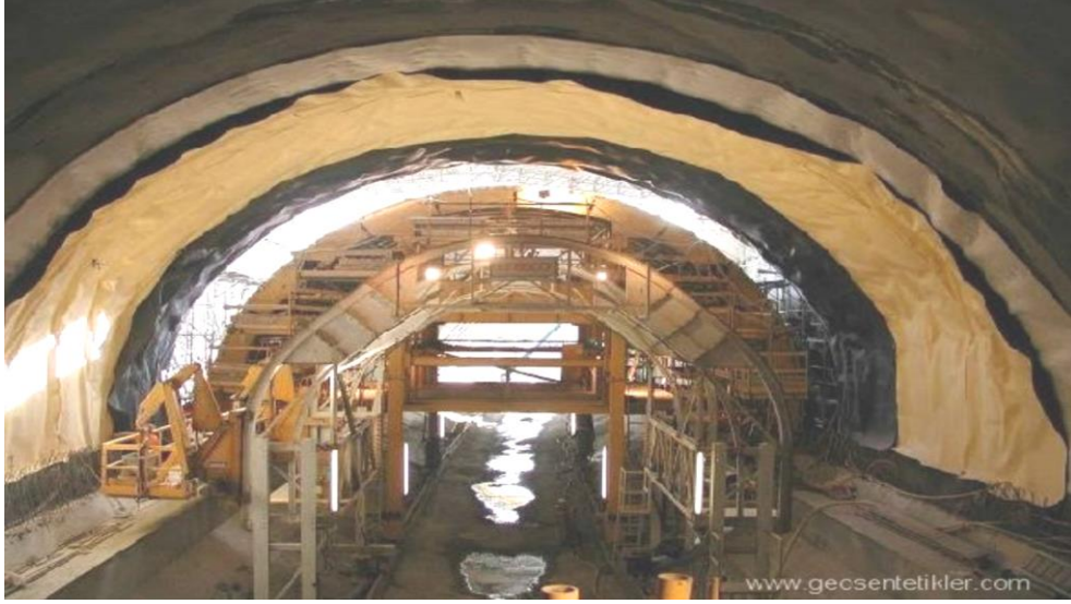
Şekil 1.39. Tünel inşaatında geokompozit kullanımı (URL-2, 2013)
