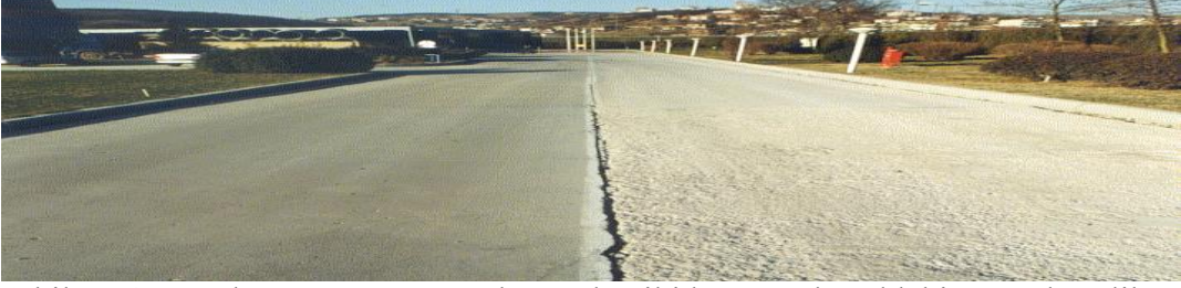
Şekil 1.24. 15 yıl önce aynı zamanda yapılan iki beton yol. Soldaki betonda çelik tel kullanılmıştır
