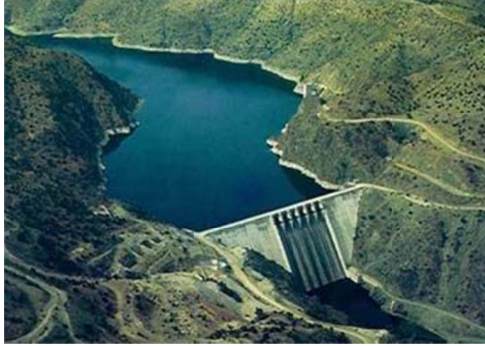
Şekil 2.1. Sarıyar Barajı'nın görünümü
