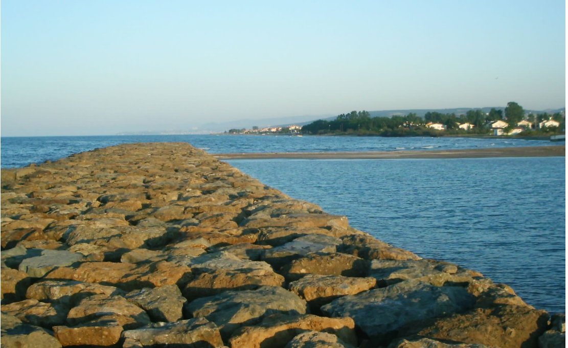
Resim 6. Açıkdeniz dalgakıranları ile kıyı şeridinin birleşimi
