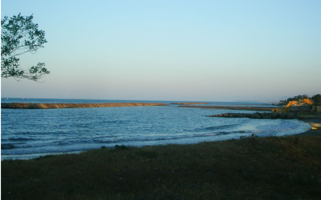
Resim 2. Açıkdeniz dalgakıranlarının kıyıda görünümü
