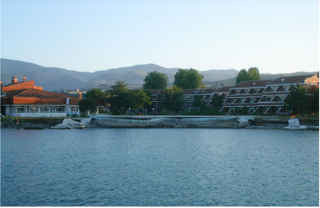
Resim 11. T mahmuzların yapımından dolayı yıkılan ve kampların önünde bulunan çevre duvarı
