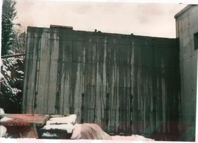
a) Ön cepheden görünüm
