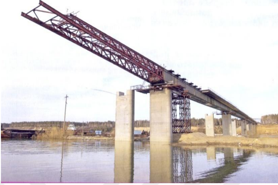
Şekil 9. İtme sürme yöntemi
