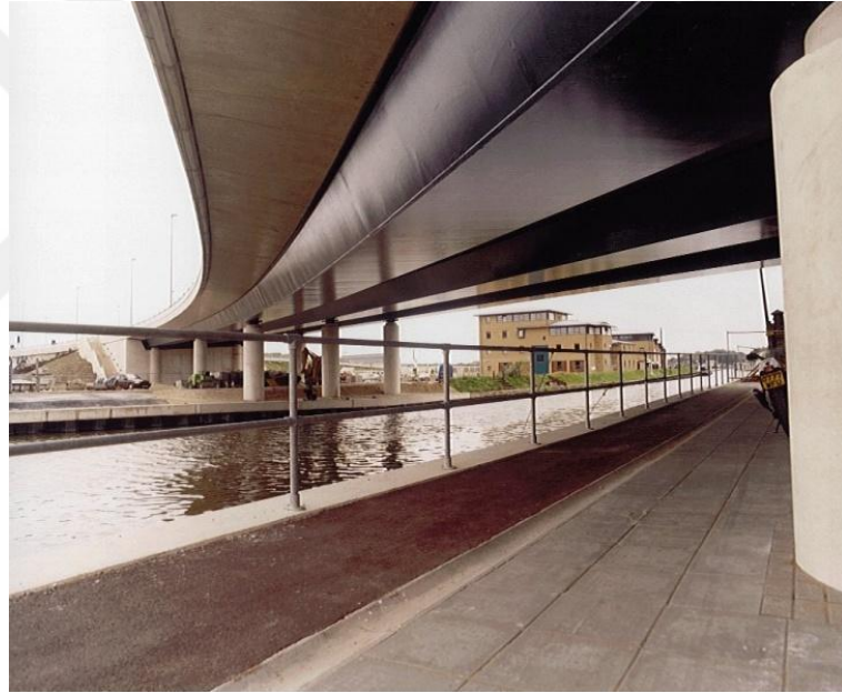
Şekil 7. Planda kavisli kutu kirişler, Fossedyke Köprüsü, Lincoln
