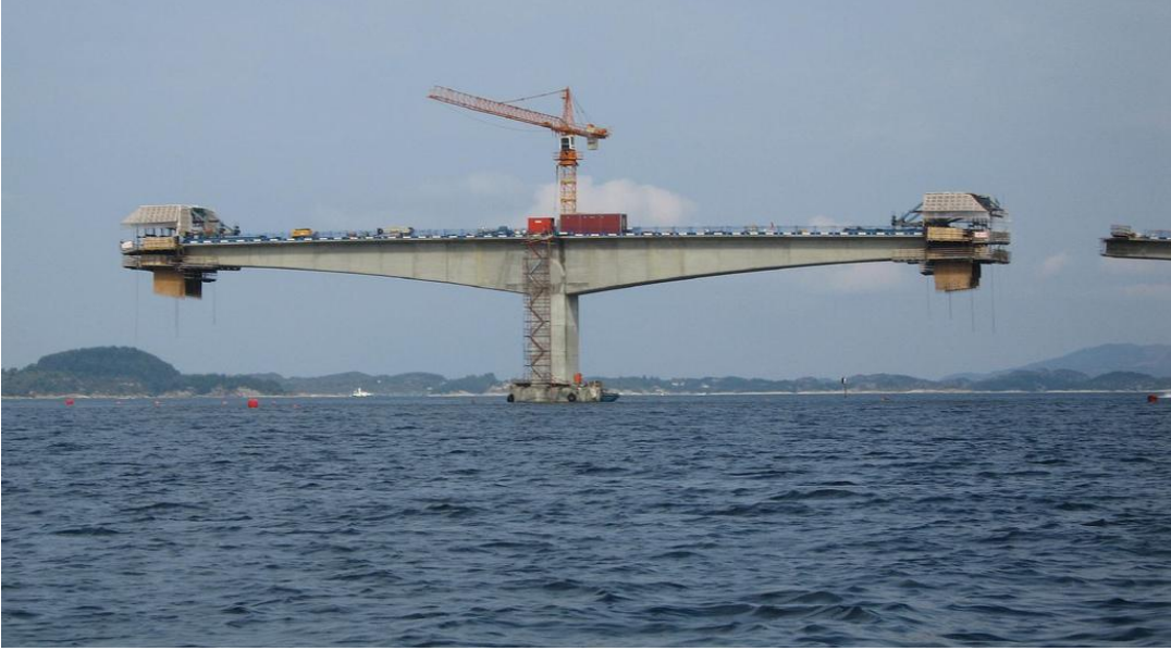
Şekil 8. Dengeli konsol yöntemi
