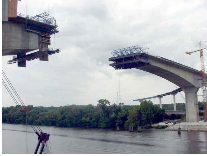
Şekil 12. Gezici kalıplı segmental inşa yöntemi
