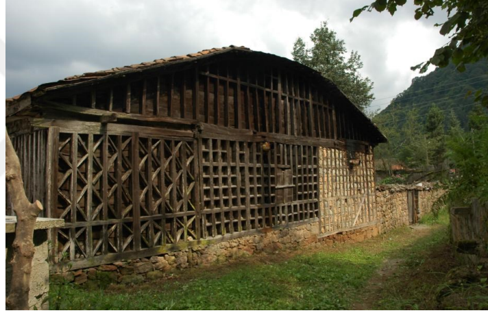
Fotoğraf 141: Kırsal Mimaride Duvar Dolgu Teknikleri
