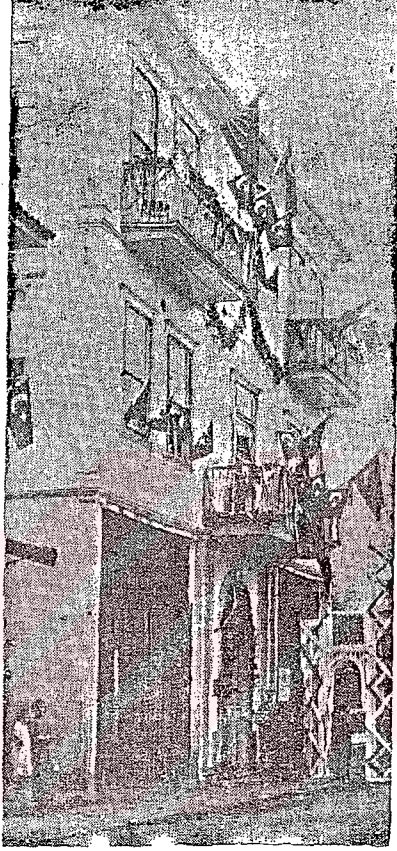
Giresun Halkevi binası (Gazi Caddesindeki -hâlen Halk Eğitimi Merkezi olarak kullanılan- 130 numaralı bina).
