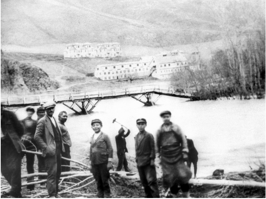
Ek 6.7. Yol Yapımında Çalışan İşçiler
