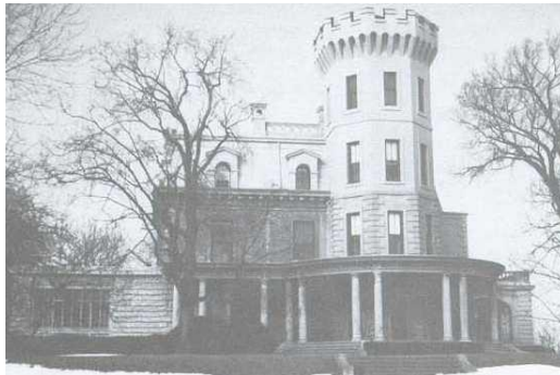
Şekil 1.4. Ward'ın betonarme tekniğini kullanarak inşa ettiği konut (URL-2, 2018)
