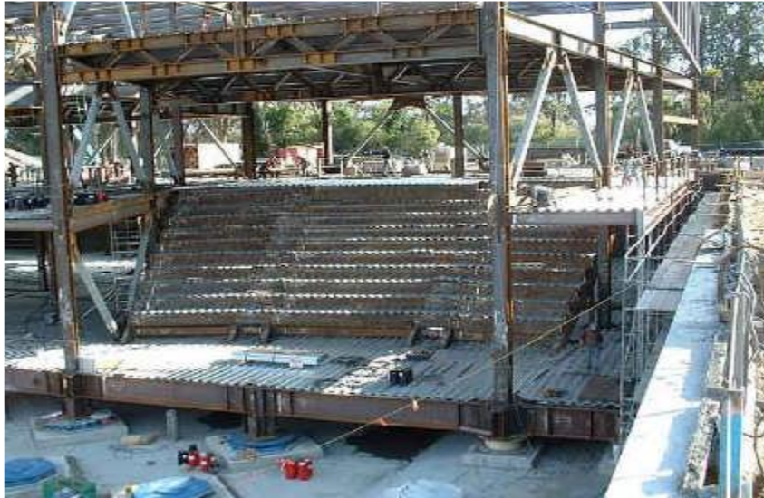
Şekil 1.16. Kauçuk ve sürtünme esaslı izolatörlerin karma sistemi olarak kullanıldığı bir çelik yapı
