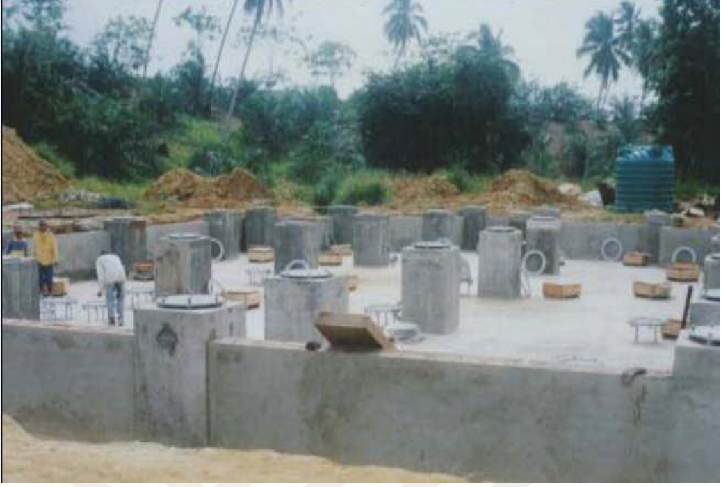
Şekil 1.12. Temel üstünde, kolon ortasında uygulanmış kauçuk sismik izolatör sistemi
