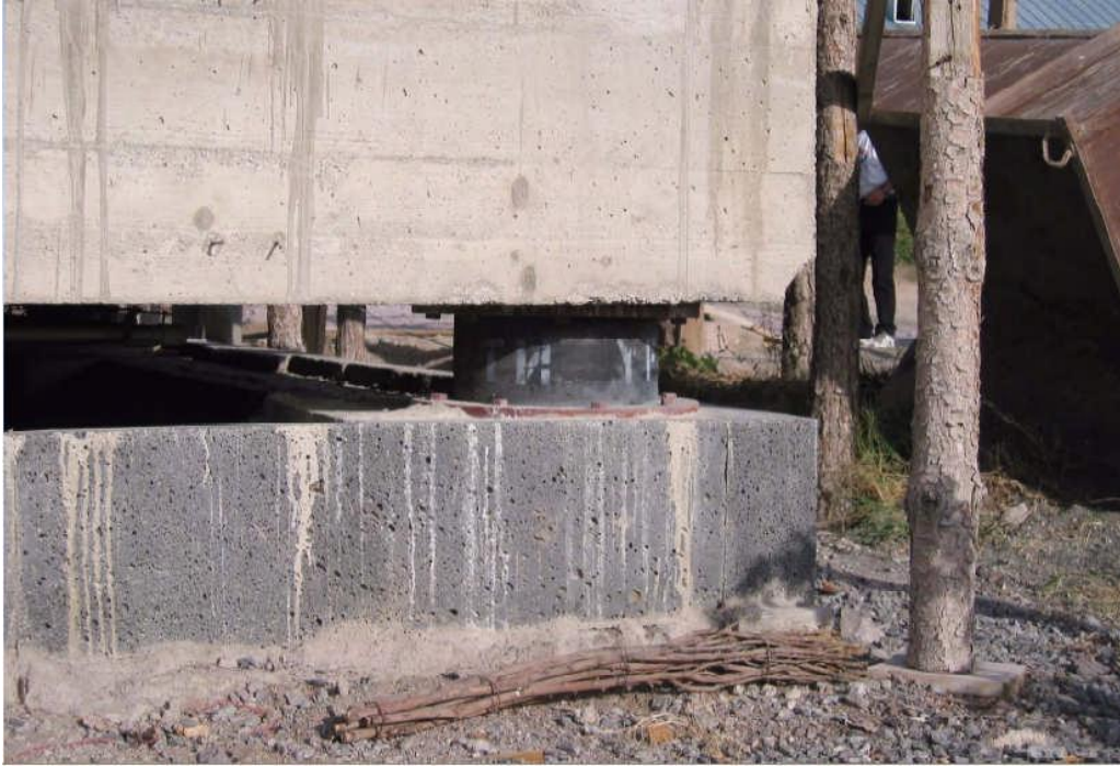
Şekil 1.13. Bir yapının köşe kolonun altına uygulanmış kauçuk esaslı sismik izolatör
