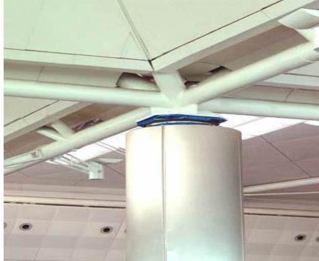
Şekil 1.18. Atatürk havalimanı çatısında kullanılan sürtünmeli sarkaç mesnet detayı
