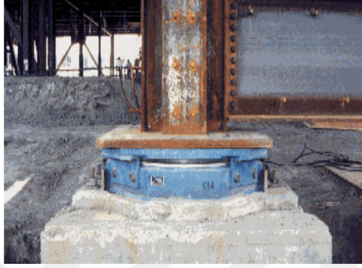
Şekil 1.17. Sürtünmeli sarkaç izolatör
