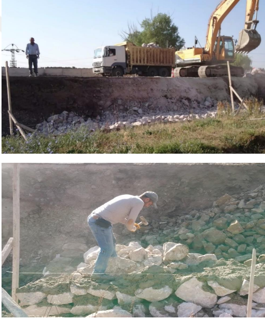
Şekil 15. Taş duvarın örülmesi
