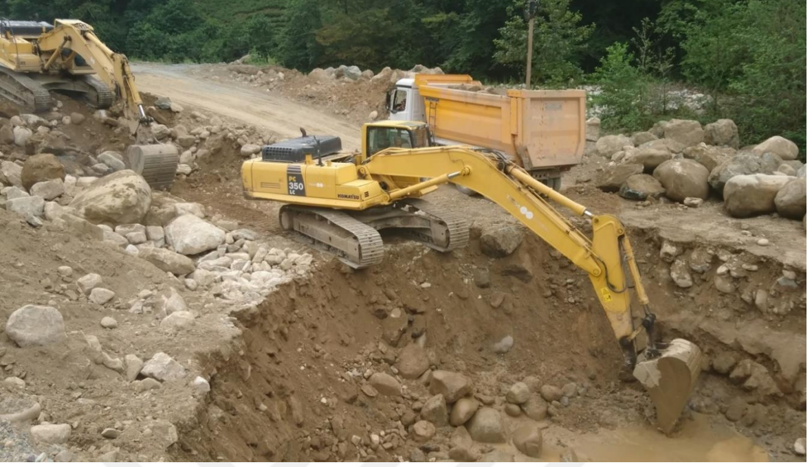
Şekil 4. Betonarme duvarın temel kazısı
