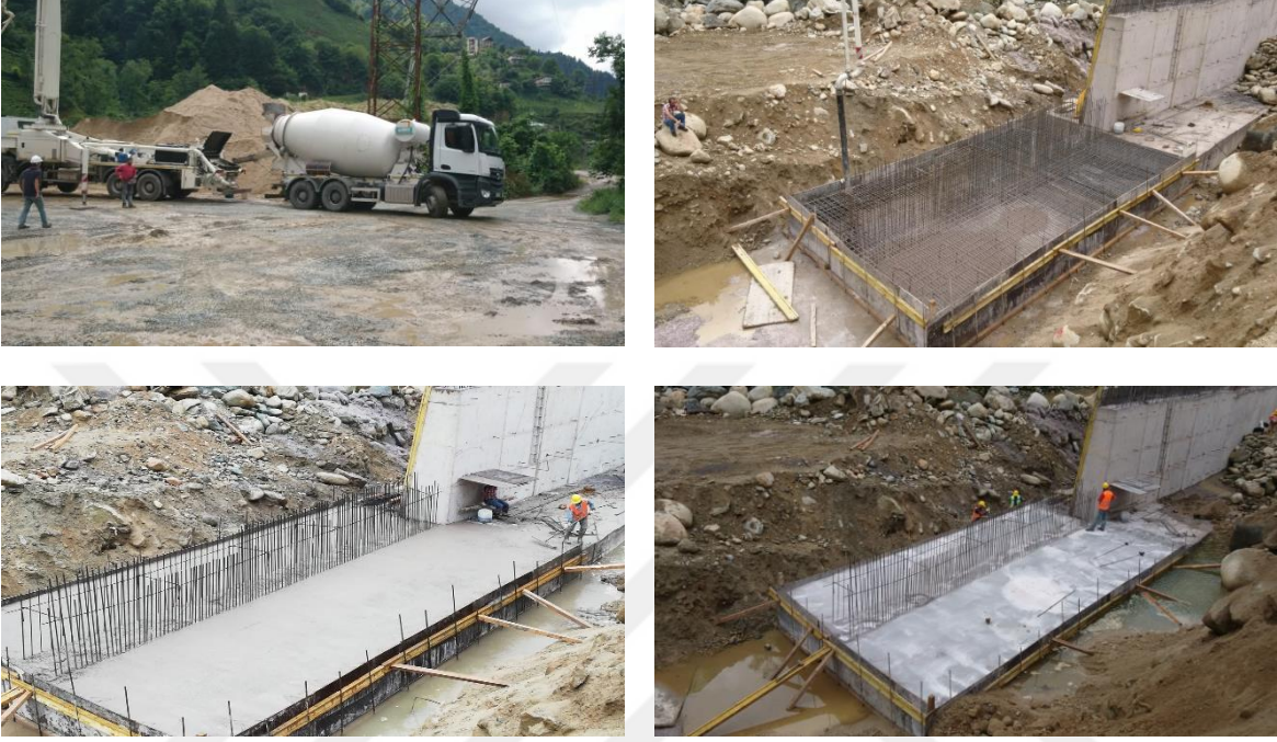
Şekil 8. Temel betonunun dökümü
