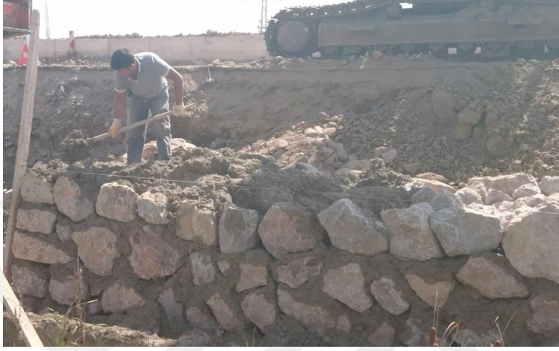
Şekil 16. Taş duvarda harcın kullanımı
