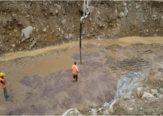
Şekil 5. Grobeton dökümü
