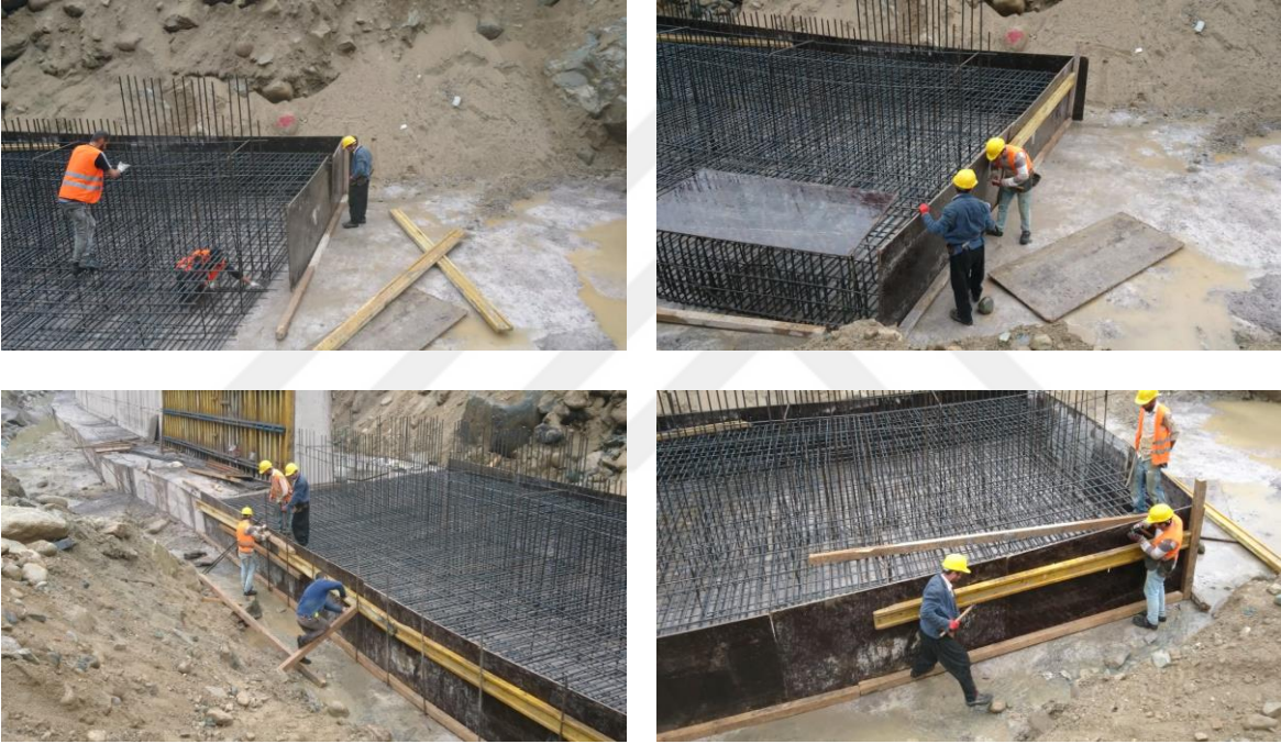
Şekil 7. Temel kalıbının imalatı
