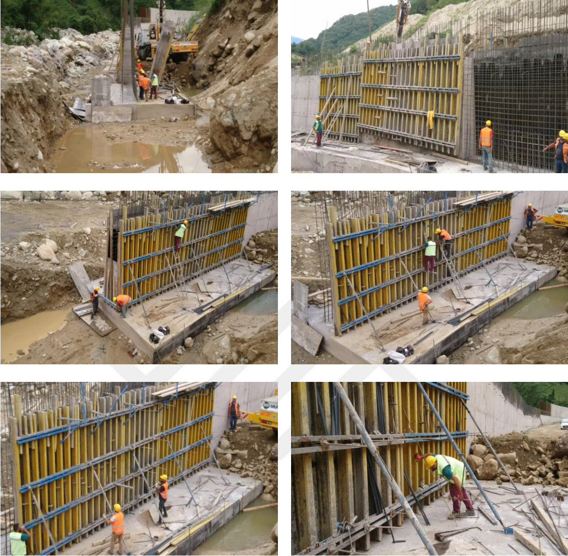
Şekil 10. Perde kalıbı yapımı
