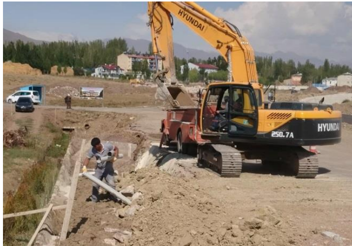
Şekil 17. Barbakanların yerleştirilmesi
