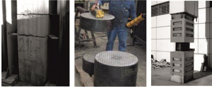
Şekil 1.14. Antalya havalimanı kauçuk izolatör uygulaması [24,42]
