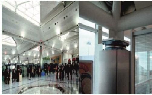
Şekil 1.13. İstanbul Atatürk havalimanı sarkaç tipi izolatör uygulaması [25].
