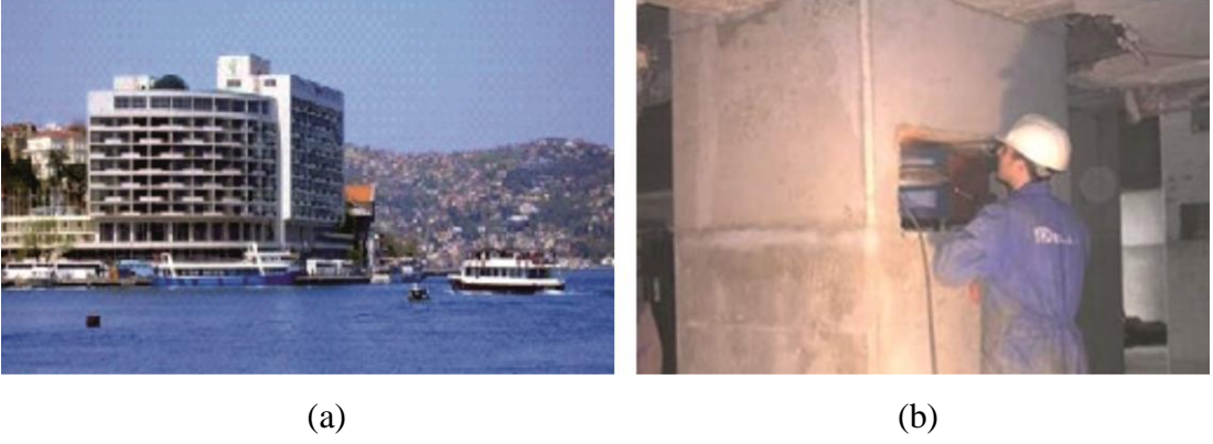
Şekil 1.16. a) Tarabya oteli ve b) kolonlarına yerleştirilen sürtünmeli sarkaç izolatör
