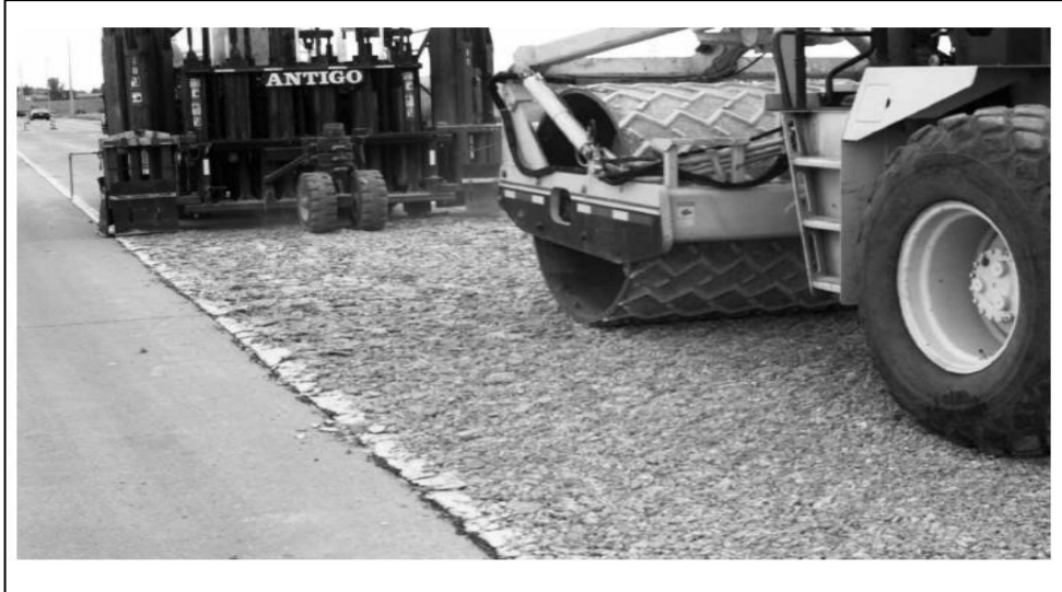
Şekil 2. 7. Beton plakaların “Rubblization” sonrası sıkıştırması (Ceylan, 2005).
