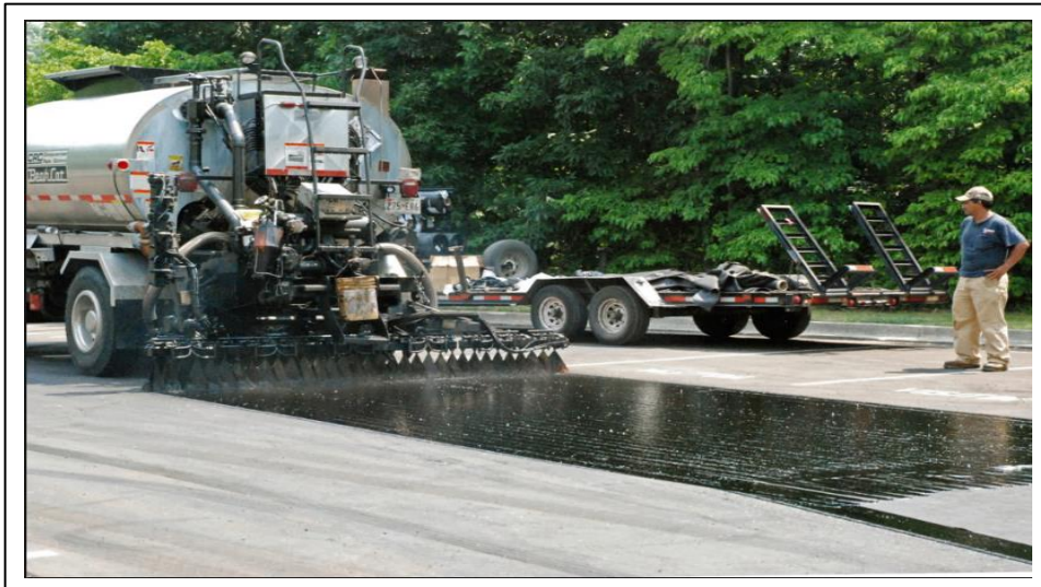
Şekil 2. 6. “Tack-coat” uygulaması (Tom Kuenmen,2016).
