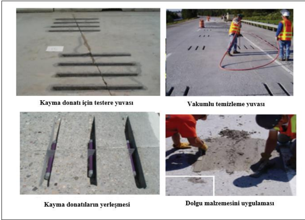
Şekil 2. 5. Kayma çubukların yerleşim prosedürü (Perkins vd., 2009).
