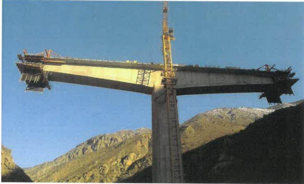
Şekil 1.11. Ortaköy Köprüsü kalıp arabasının ilerletilmesi
