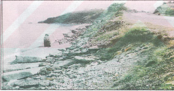
Şekil 2.3.6. Dalgalara dayanamayan bir dayanma yapısı (Zeytinlik Köyü)
