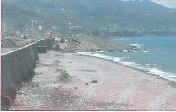
Şekil 2.3.12. Eynesil'de istinat duvarı yapılarak kumsal kurtarılmıştır
