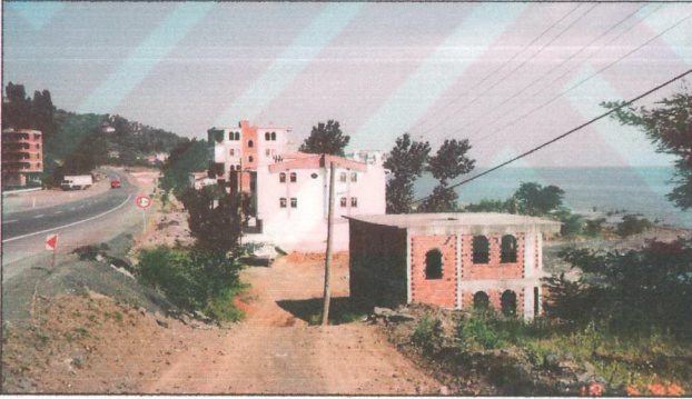
Şekil 2.3.9. Karadeniz Bölünmüş Sahil Yolu çarpık kentleşmeye neden olmakta (Çatalzeytin mevki)
