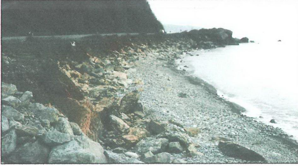
Şekil 2.3.5. Dalgalar tahkimatın altını yavaş yavaş oymakta
