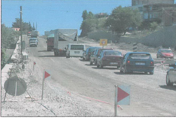
Şekil 2.3.23. Yapım çalışmaları nedeniyle araç konvoyları oluşmakta (Eynesil)
