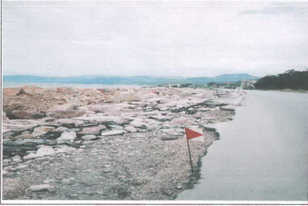
Şekil 2.3.8. Bazı kesimlerde yol dalgalar nedeniyle bozulmakta (Piraziz'in doğusu)
