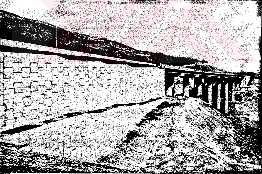
Şekil 21. TAG otoyolu Nur Dağı geçişi inşaatı [41].
