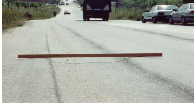
Şekil 1. Tekerlek izinde yapısal oturma örneği [8]
