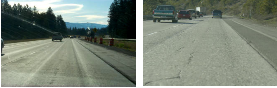
Şekil 6. Çivili lastiklerin yol üzerindeki hasarları [8]
