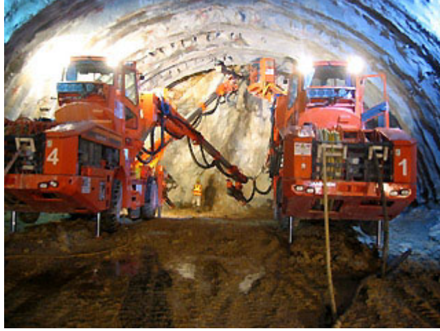
Şekil 1.16. Jumbo aygıtıyla patlayıcıların yerleştirileceği lağım deliklerinin açılış anında bir görünüm
