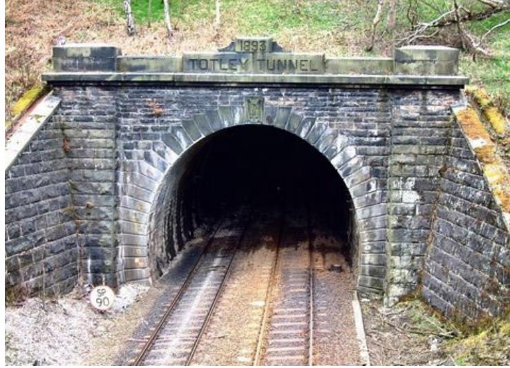
Şekil 2.1. Kesme taş kaplamalı 1893’de inşa edilen Totkey Tünelinden bir görünüm (URL-6,2007)
