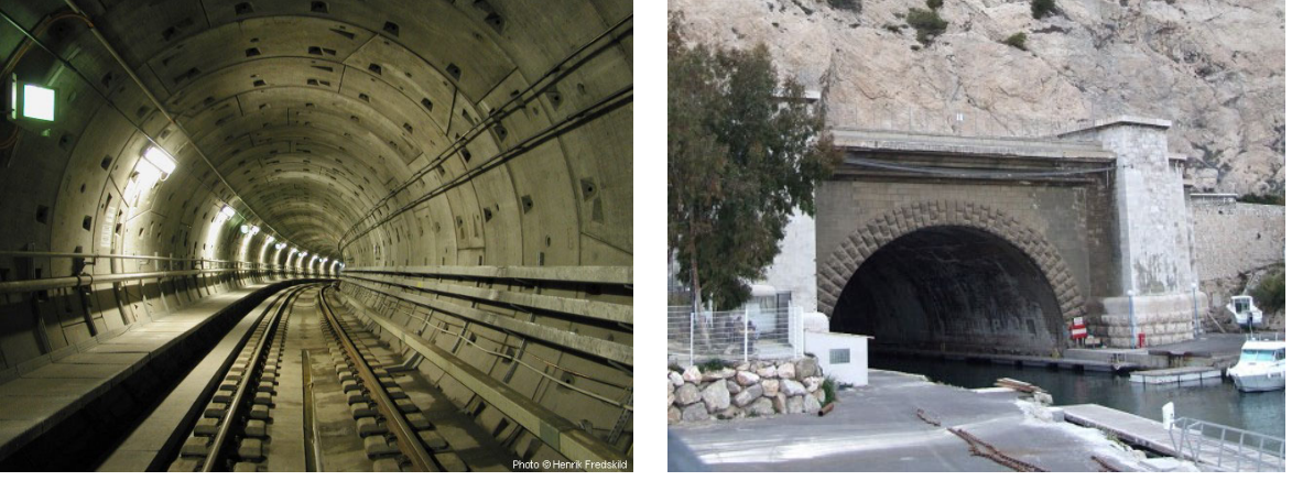
Şekil 1.4. Metro ve kanal tünellerinden örnek birer görünüm (URL-1,2007;URL-2,2007)
