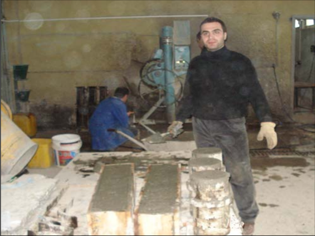
Şekil 32. Üretilen kolonlar ve standart silindir numuneler
