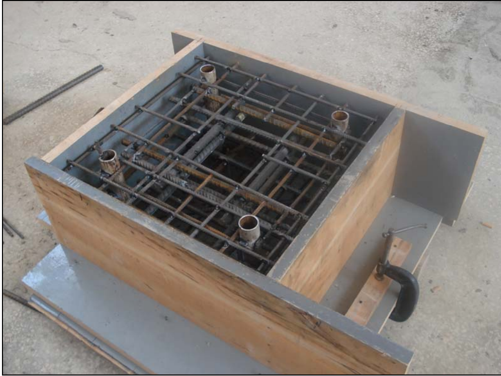
Şekil 36. Kolonların yerleştirildiği temel sistemi
