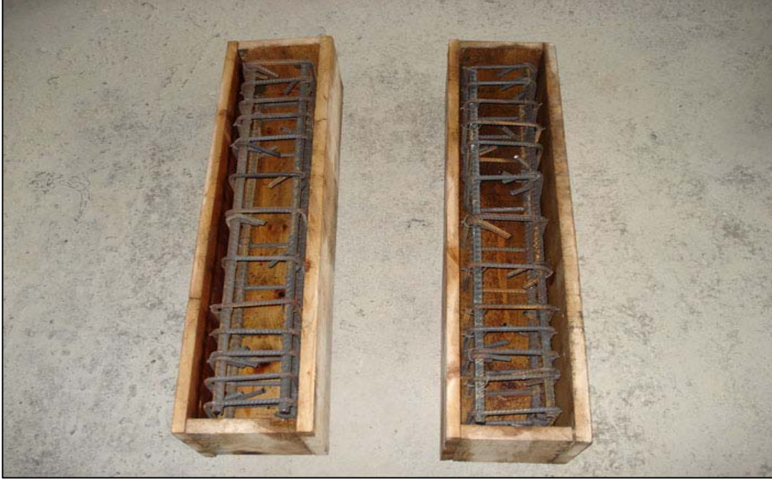
Şekil 29. Betonarme kolon donatı ve kalıpları
