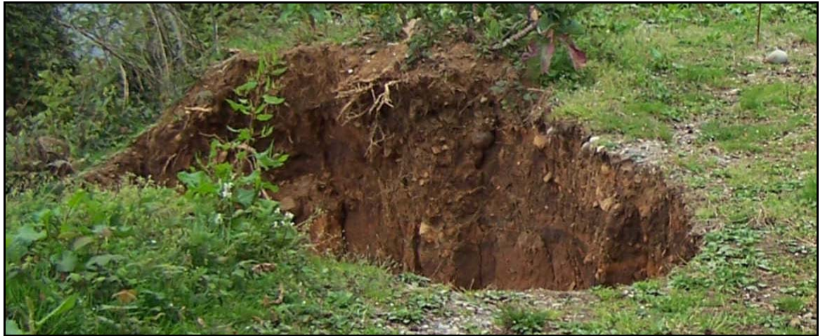
Şekil 27. Heyelanın taç kısmında oluşan gerilme (çekme) çatlağı
