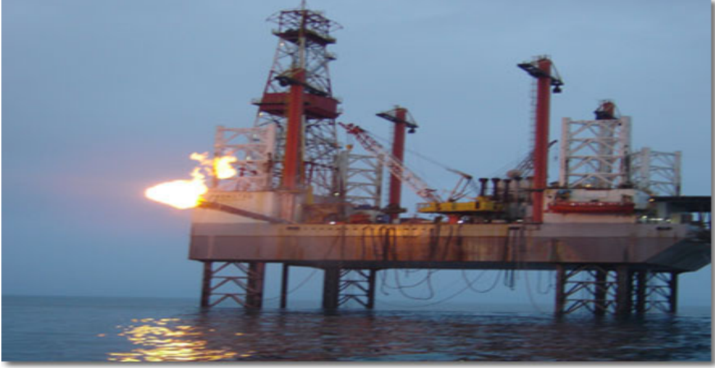
Őekil 47. Akkaya’daki platform [63].
