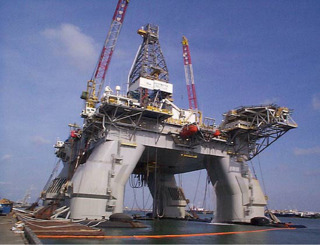
Şekil 7. Açık deniz yapısının kurulumu [51].
