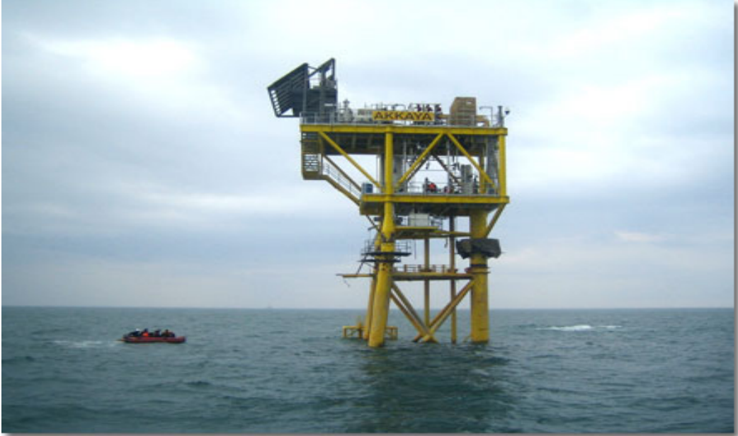
Őekil 48. Akkaya’daki platform [63].
