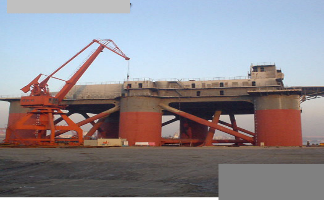
Şekil 6. Açık deniz yapısının kurulumu [50].
