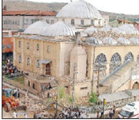
Şekil 1.4. Kahramanmaraş'ın Afşin İlçesindeki Ulu Caminin rüzgâr nedeniyle yıkılmış minaresi (Gönen, 2005).
