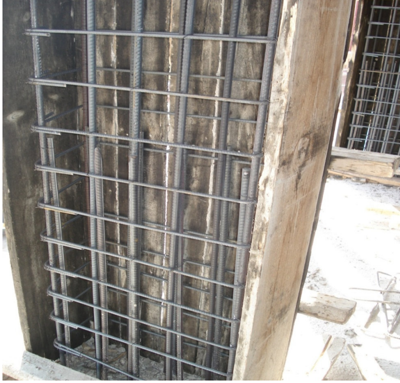
Şekil 2.3. Enine donatı kolları ve/veya çirozlar arasındaki en büyük mesafe şartına uyulmaması
