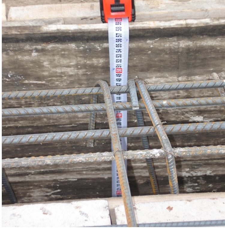
Şekil 2.11. Kiriş yüksekliği şartına uyulmaması
