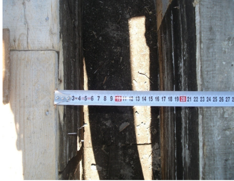
Şekil 2.10. Kirişlerde gövde genişliği şartına uyulmaması
