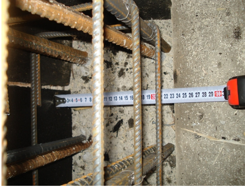
Şekil 2.5. Kolonlarda minimum enkesit boyutu kuralına uyulmaması
