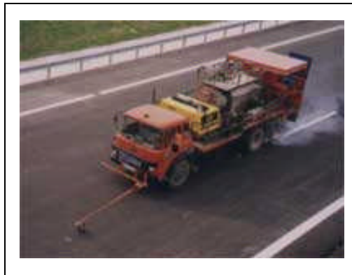
Şekil 2. GRS termoplastik yol çizgi boyası uygulaması [8].
