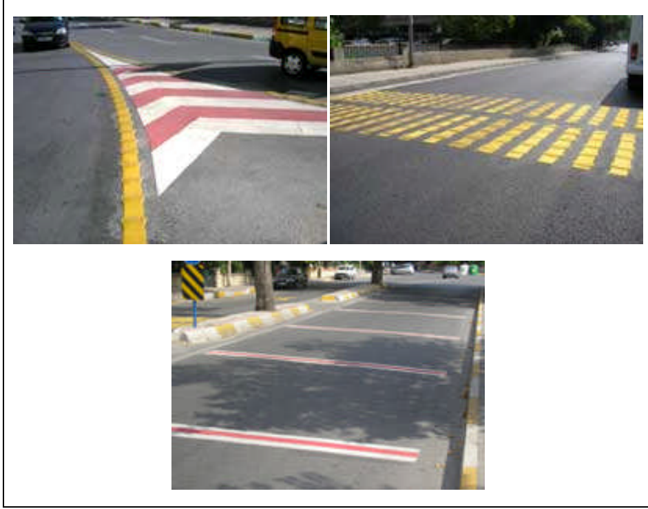
Şekil 3. İki kompenantlı boya yardımıyla uygulanan hız kesiciler [6]
