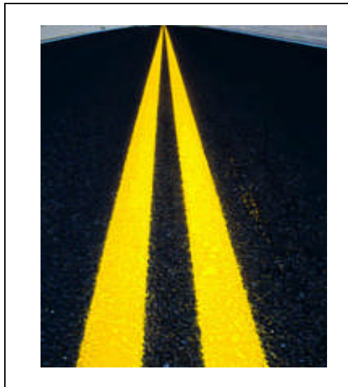
Şekil 1. Yatay işaretlemede termoplastik boya uygulaması [10].
