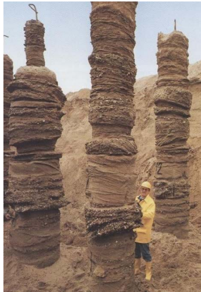
Şekil 35. Jet enjeksiyon yöntemi ile oluşturulmuş kolonlar
