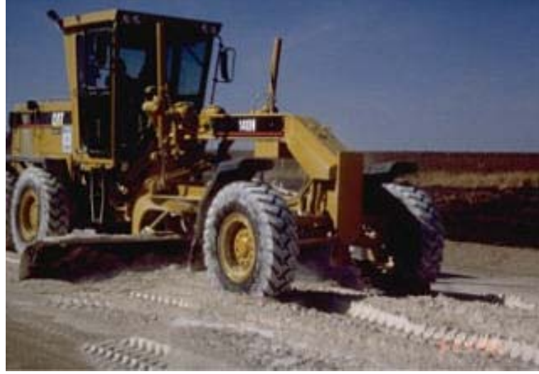
Şekil 4. Uçucu kül ile iyileştirilmiş yol yapımı
