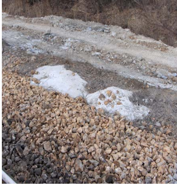
Şekil 52. Jet enjeksiyon uygulamasından sonra sahanın durumu
