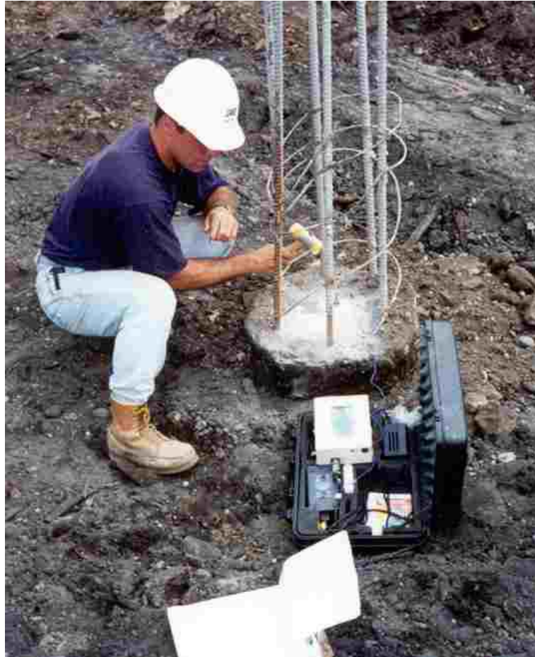
Şekil 42. Integrity test uygulaması
