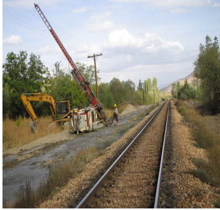
Şekil 49. İslah gerçekleştirilecek alanda jet enjeksiyon uygulaması
