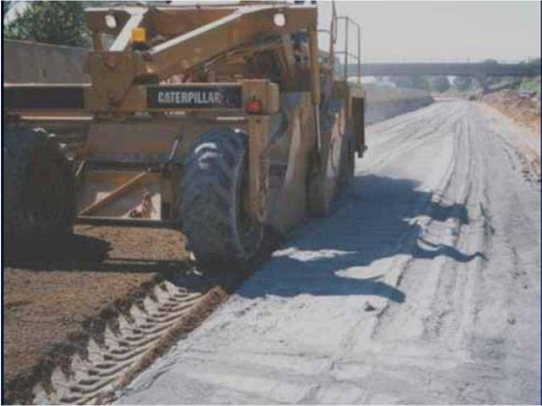
Şekil 3. Çimento ile stabilizasyon uygulaması
