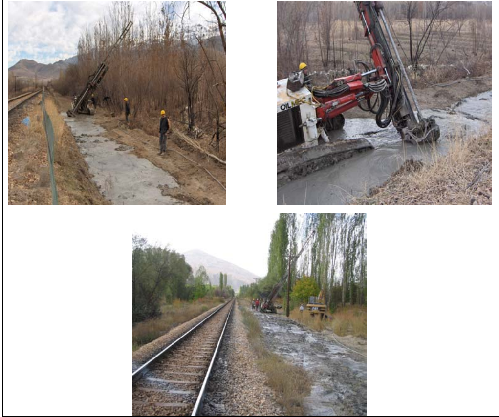
Şekil 50. Jet enjeksiyon uygulaması çalışmaları
