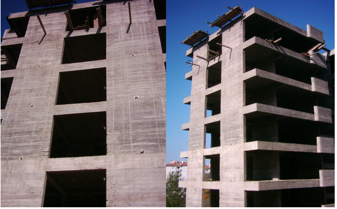
Şekil 7. Betonarme perde sistem bir yapı
