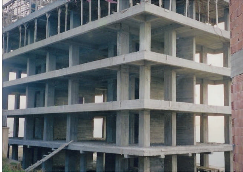
Şekil 11. Betonarme perde-çerçeve sistem bir yapı
