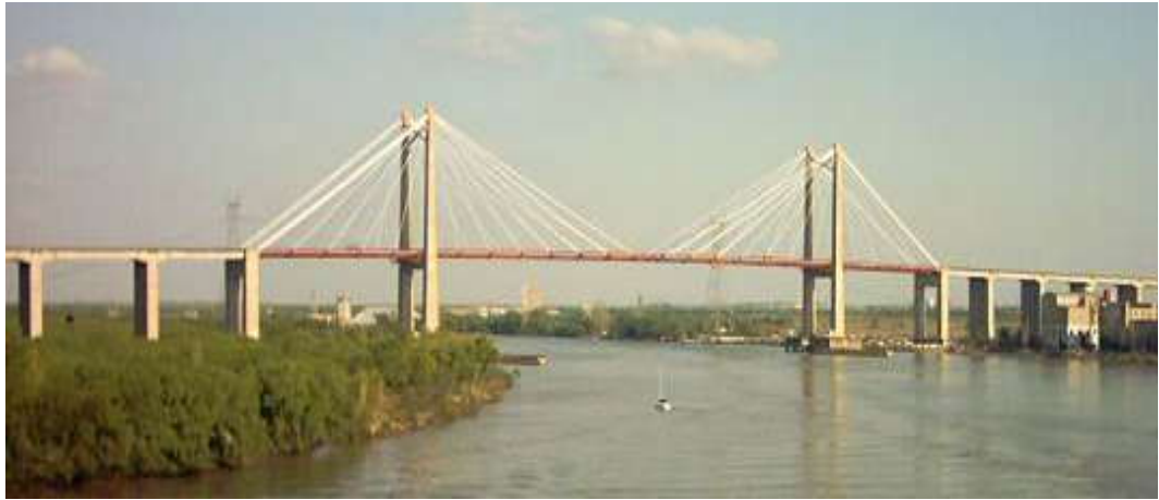
Şekil 12. Zarate-Brazo Largo Kablolu köprüsü
