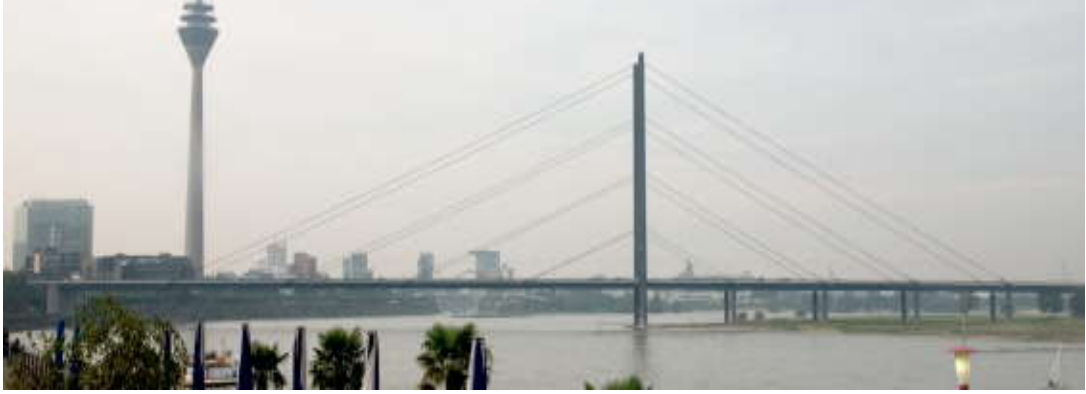
Şekil 7. Knie Kablolu Köprüsü
