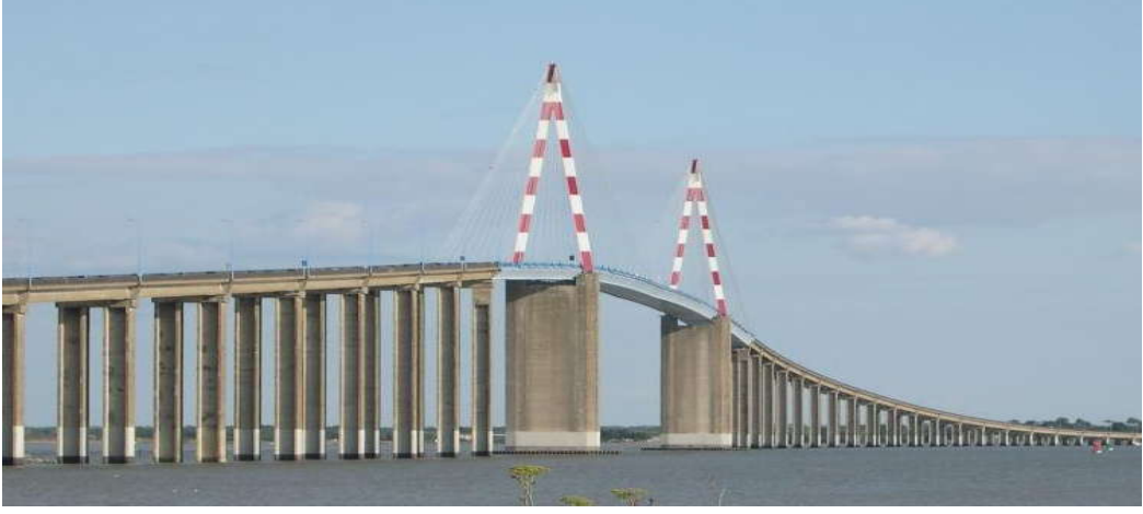
Şekil 10. Saint Nazaire Kablolu köprüsü
