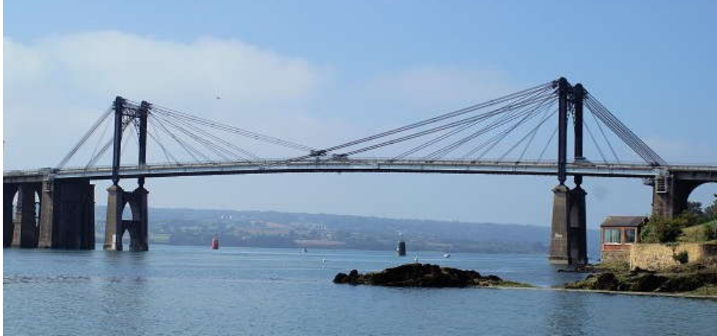
Şekil 1. Lezardrieux Kablolu Köprüsü
