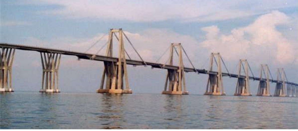
Şekil 5. Maracaibo Kablolu Köprüsü
