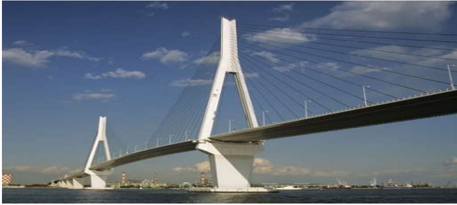
Şekil 16. Tsurumi Tsubasa Kablolu Köprüsü
