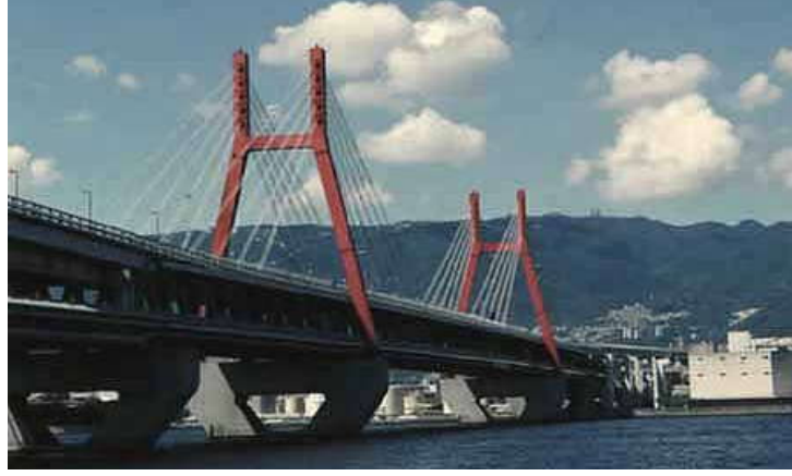
Şekil 14. Rokko Kablolu Köprüsü
