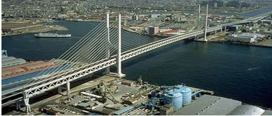
Şekil 15. Higashi Kobe Kablolu Köprüsü
