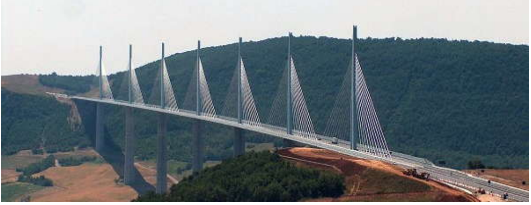
Şekil 20. Millau Viaduct Kablolu Köprüsü
