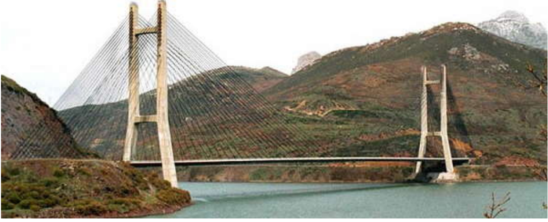
Şekil 13. Barrios De Luna Kablolu Köprüsü
