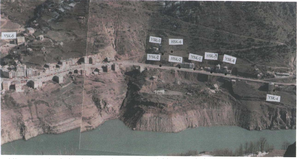
Şekil 31. Heyelan bölgesinde yapılan temel sondaj kuyu yerleri
