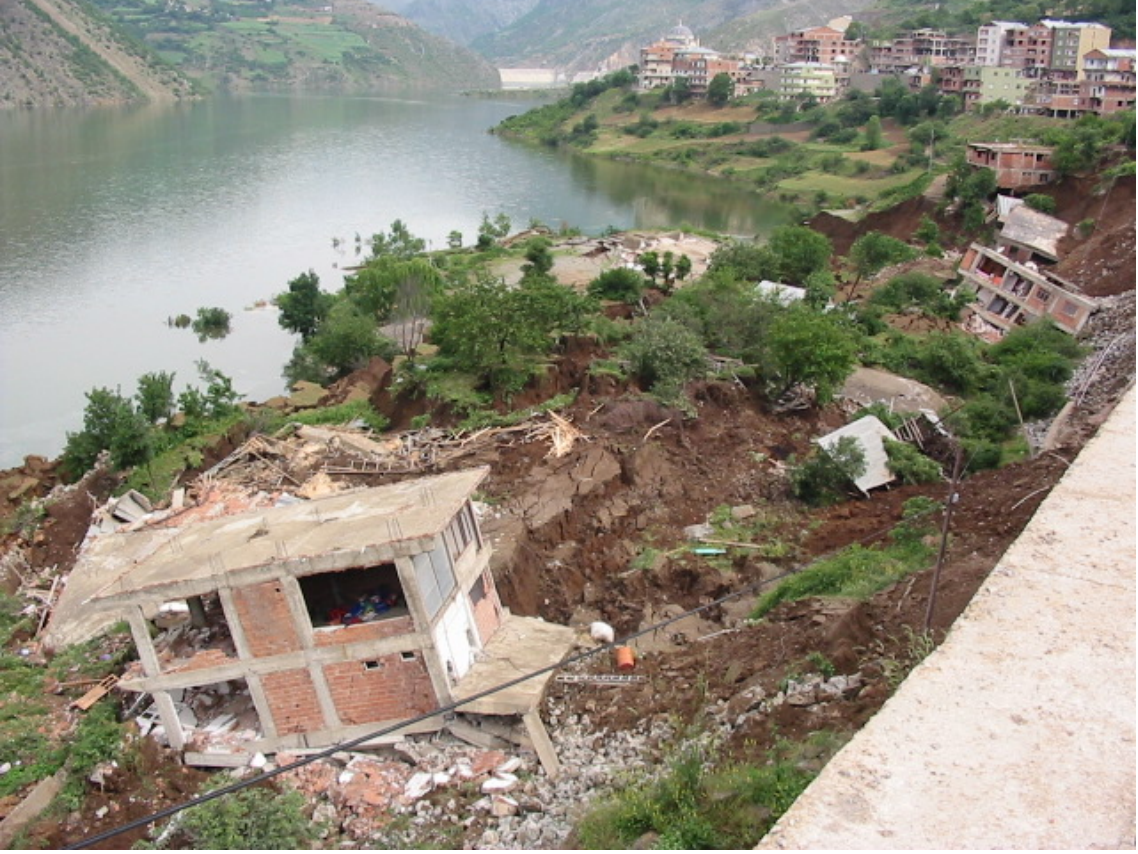
Şekil 29. Heyelan sonucunda hareket eden evler
