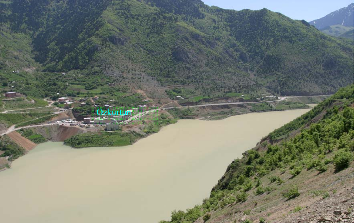
Şekil 30. Heyelandan sonra Özkürtün beldesinden genel bir görünüm
