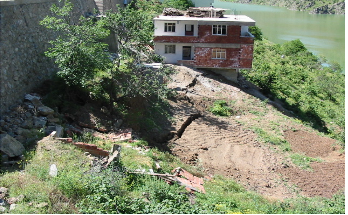
Şekil 27. Arazide oluşan çatlaklar
