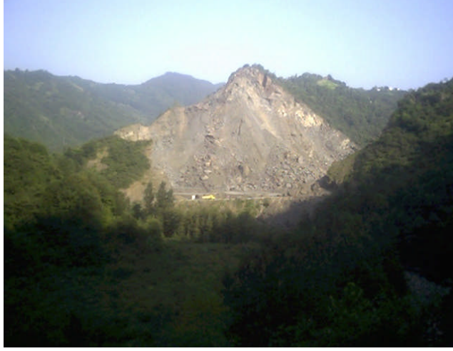
Şekil 10. Taşocağında yüksek-geniş çalışma aynası ve şapka şeklinde kalan üst kısım (Kesimal vd., 2007)
