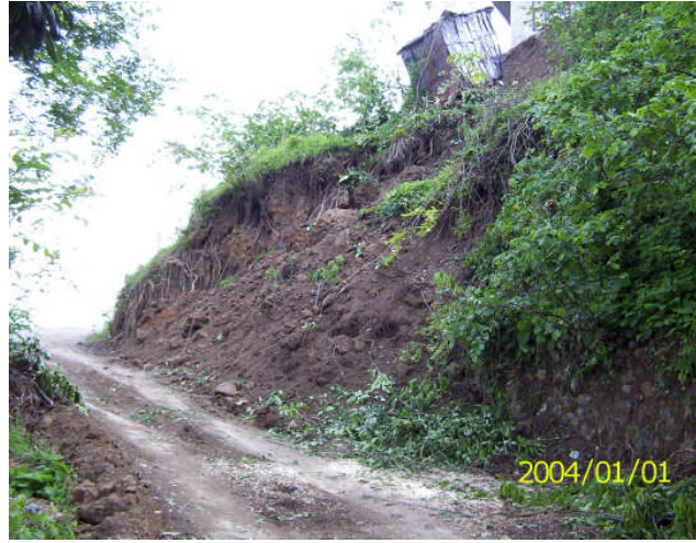
Şekil 8. Patlatma nedeniyle oluşan heyelan ve evin hasar görmesi (Kesimal vd., 2005, 2008)
