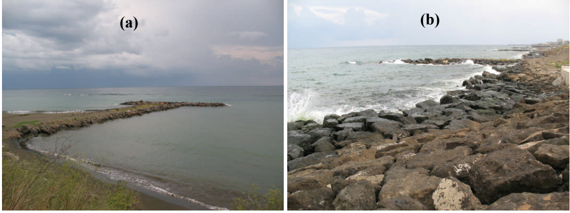
Şekil 2. Kıyıya dik (a) ve paralel (b) koruma yapıları
