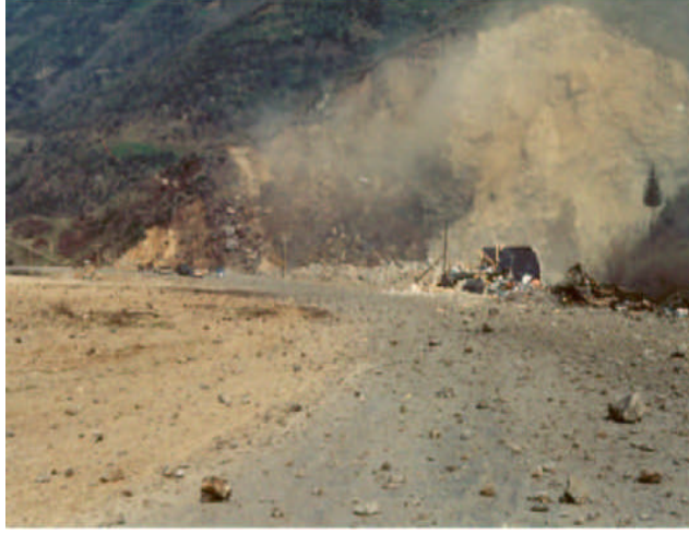
Şekil 9. Galeri patlatması nedeniyle oluşan taş fırlaması (Kesimal ve Kaya, 2002)
