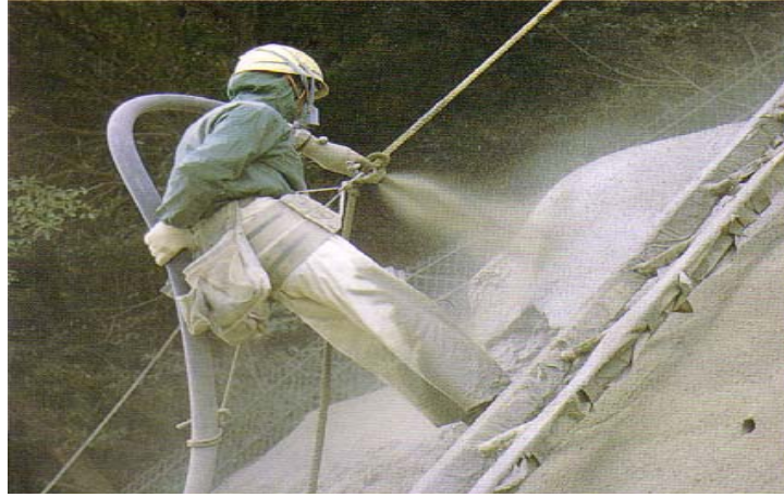
Şekil 1.8. Çelik lifli betonla şev stabilizesi
