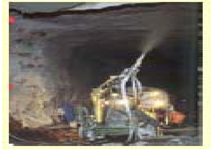
Şekil 1.12. Tünellerde çelik lifli betonun püskürtmeyle kullanımı
