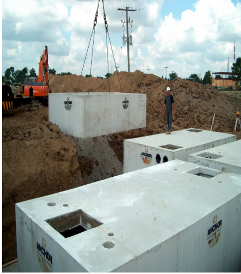
a)Dikdörtgen yerüstü deposu
