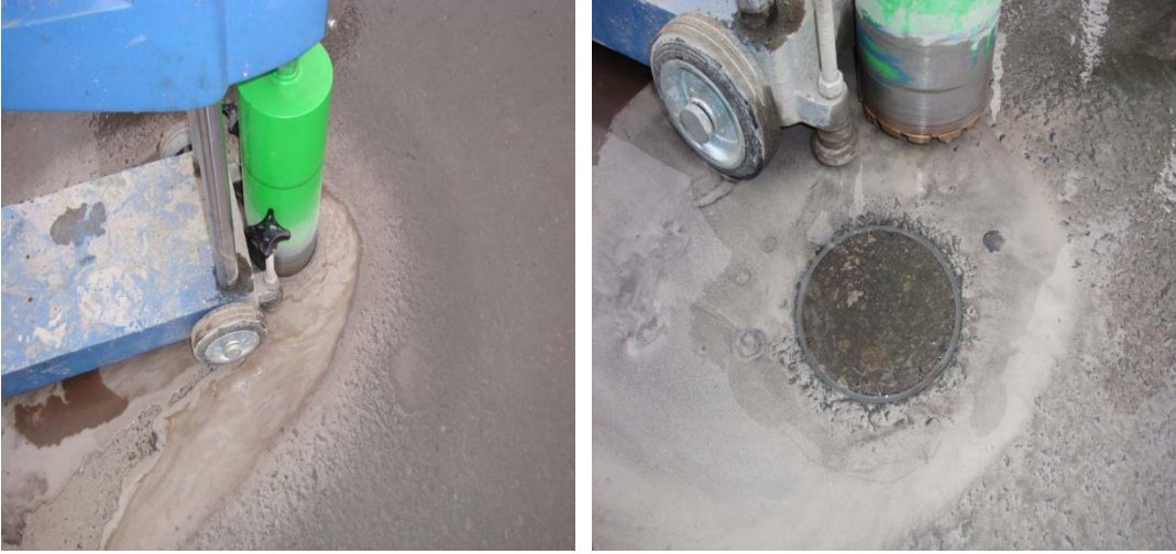
Şekil 2.2. Asfalt yoldan karot numune alımı
