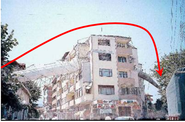
Şekil 1.18. Çevredeki bina üzerine yıkılan minare (Hürriyet 2006).
