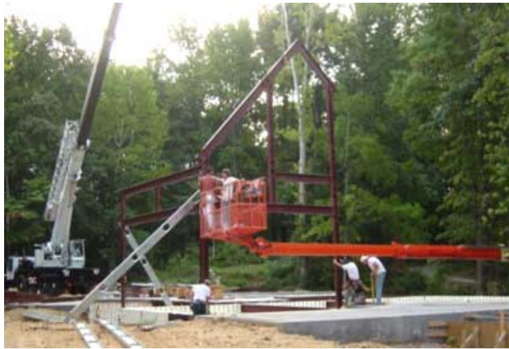
Şekil 12. Pano ve çerçeve eleman halinde yerleştirilen sistem [14]
