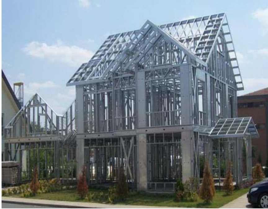
Şekil 36. Tipik bir hafif çelik yapı iskeleti
