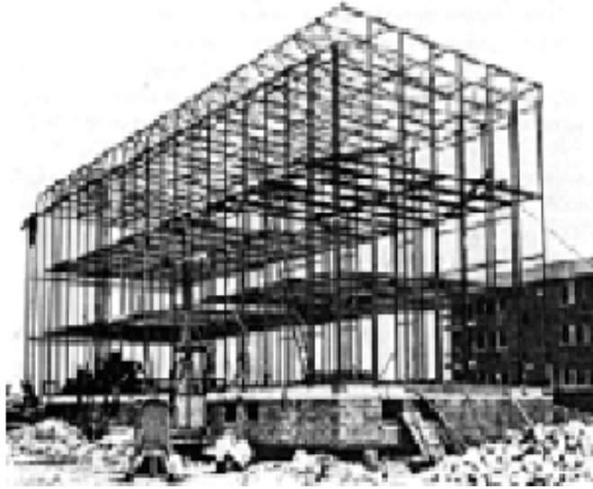
Şekil 8. İlk hafif çelik yapı sistemi
