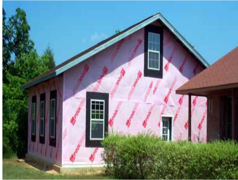
Şekil 35. Dış etkenlere karşı kaplama ile koruma
