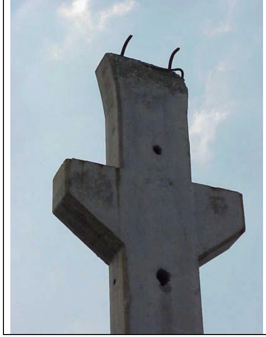
Şekil 94. Pimli bağlantı
