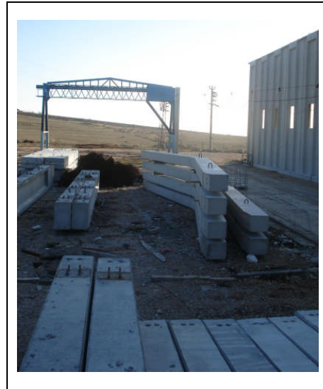
Şekil 11. Prefabrike çatı kirişi [11]
