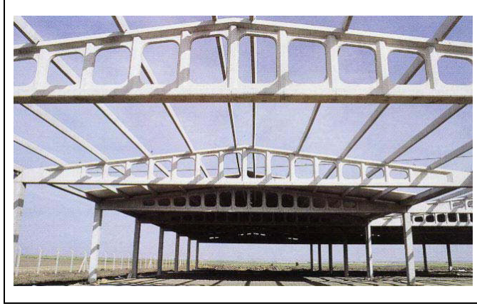
Şekil 16. Prefabrike boşluklu makas [11]
