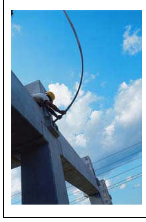
Şekil 45. Ard-germe Halatlarının Sürülmesi [19]
