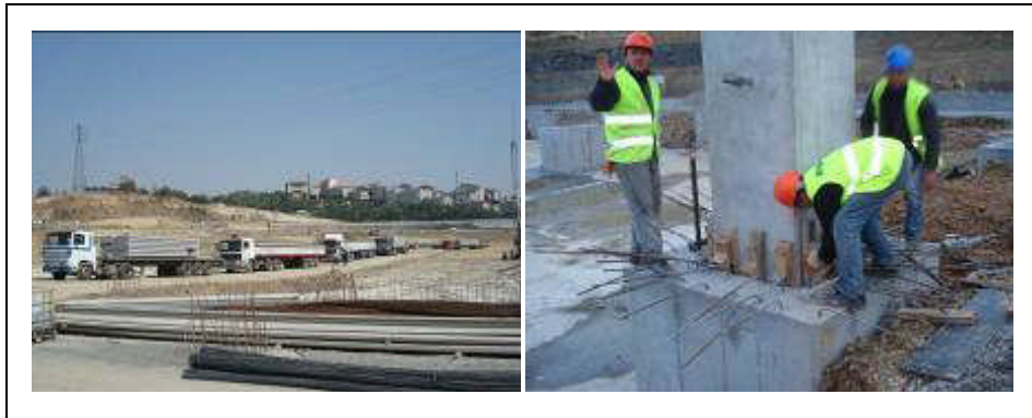
Şekil 42. Nakliye ve kolon montajı [19]
