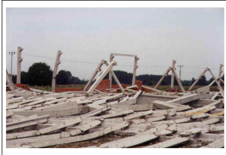
Şekil 95. Kolonların ayakta kaldığı, kirişlerin tümünün yere düştüğü yapı
