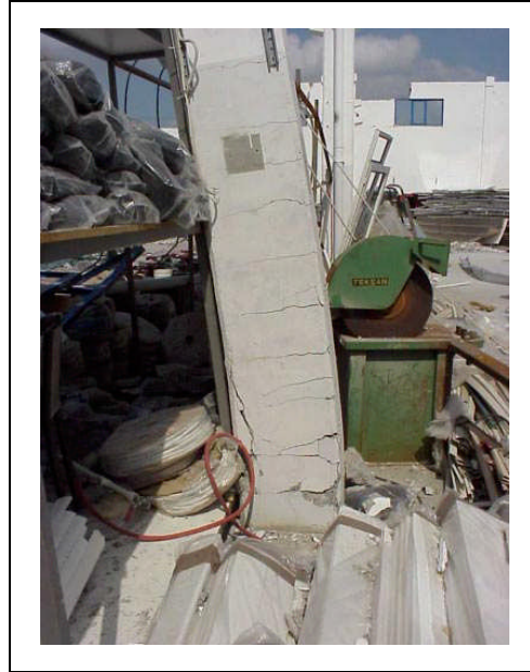
Şekil 99. Kolon alt kesiminde dönme
