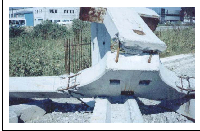
Şekil 101. Kolon başlıklarının yere düşmesi
