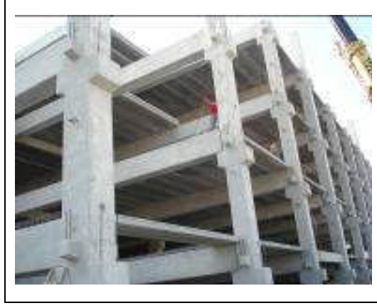
Şekil 43. Kiriş ve döşemelerin montajı [19]
