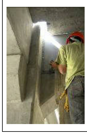
Şekil 44. Kolon-kiriş birleşim derz dolgusu [19]
