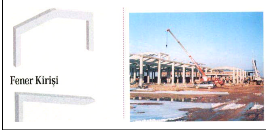
Şekil 15. Prefabrike fener kirişi [5]
